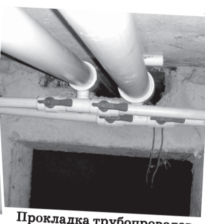
Прокладка трубопроводов из полипропилена в подвале дома № 68 на Кооперативной
