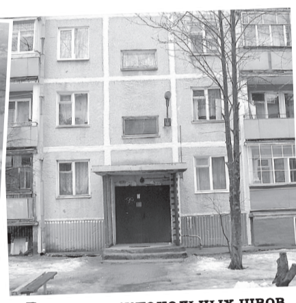
Ремонт межпанельных швов дома № 68 на Кооперативной
