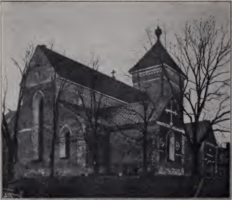
Fig. 19. Bondkyrkan, sedd från nordost.
