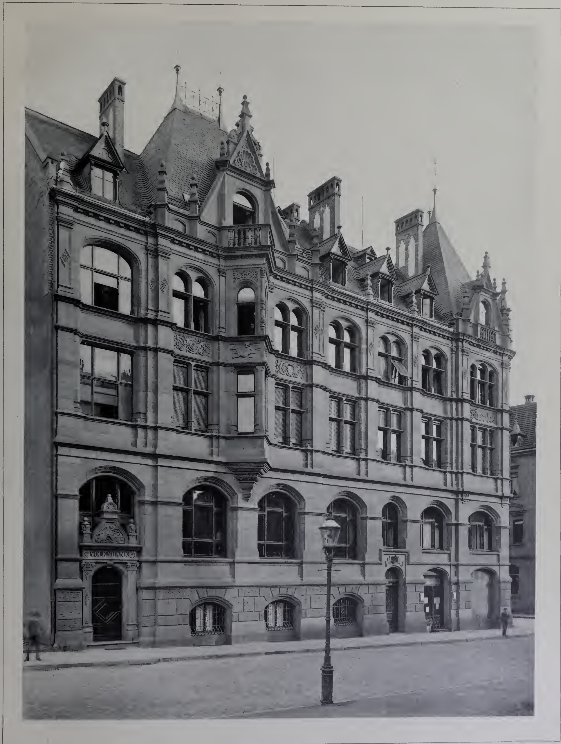
Architekt: W. Martens, Charlottenburg.
