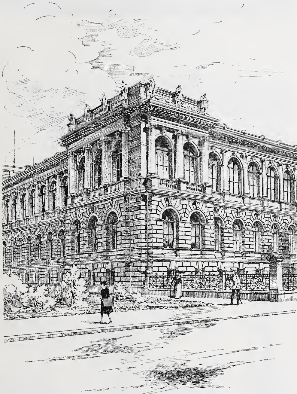
Abb. 1. Allgemeines Collegiengebäude. Rechter Eckbau. Aus dem Werke: Strafsburg und seine Bauten.
