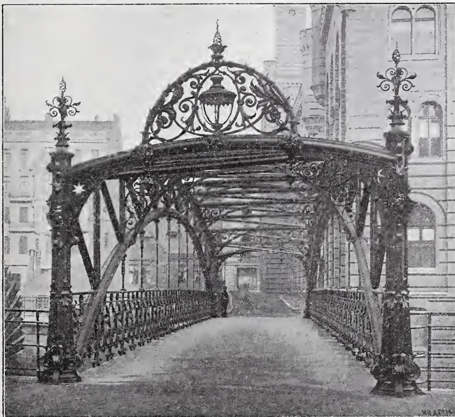
Abb. 8. Fußgängerbrücke im Zuge des Mühlenweges über dem großen Gerinne. Bauten am Mühlendamm in Berlin.
