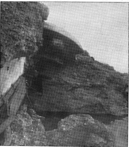
Don seiten des Generalstabes wurden uns obenstehende Bilder aus dem Panzerfort Loucin der Festung Lüttich zur Verfügung gestellt. Sie geben eine podende Darstellung der furchtbaren Wirkung des deutschen 42-cm-Belagerungsmörfers, dessen Eisenbeschuß die härteste Beton- und Panzerdecke durchdringt.
