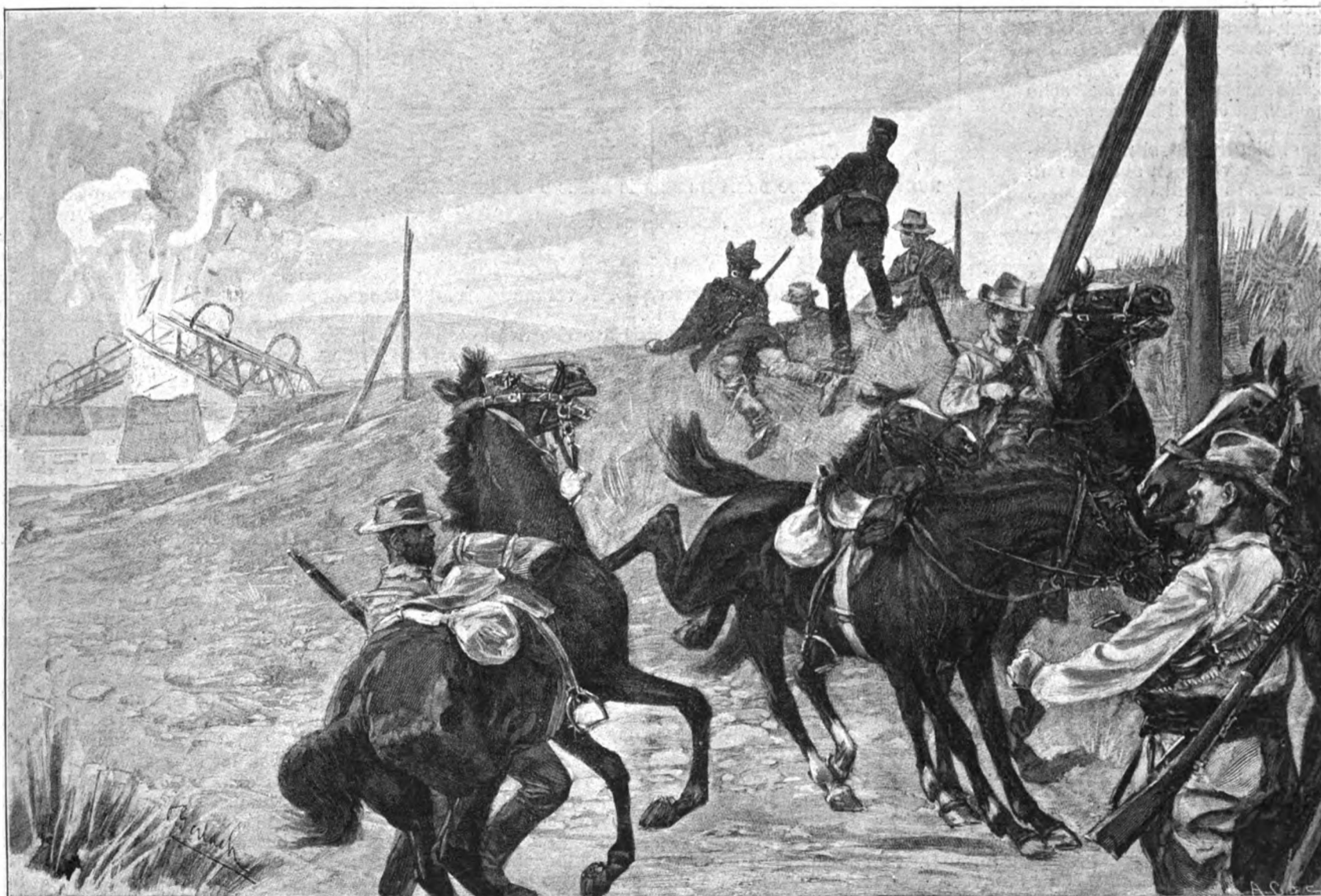
VOLADURA DE UN PUENTE DEL FERROCARRIL EN LAS CERCANÍAS DE FRERE, AL SUR DE LADYSMITH.
