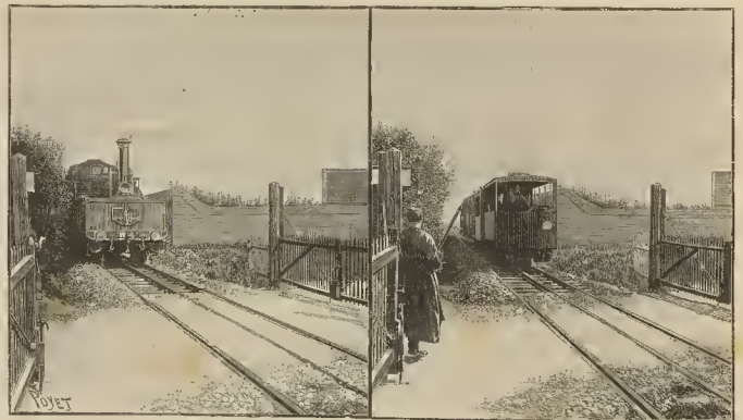
Fig. 1. — Paso del tren por la vía ancha
