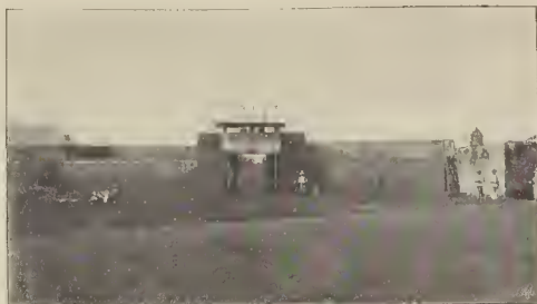
COLONIA DE PONAPÉ. — Vista interior de un trozo de la muralla que circunvala la pequeña población de Ponapé ó La Ascensión
