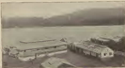
CAROLINAS ORIENTALES. - Edificios que constituían la Estación Naval Española de Ponapé, actualmente estación de carbón española
