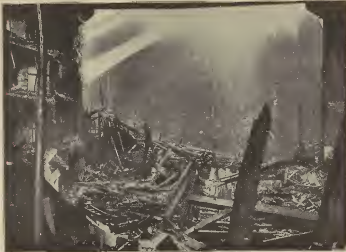
PARÍS. — Incendio del Teatro Francés. Interior de la sala de espectáculos después del siniestro
