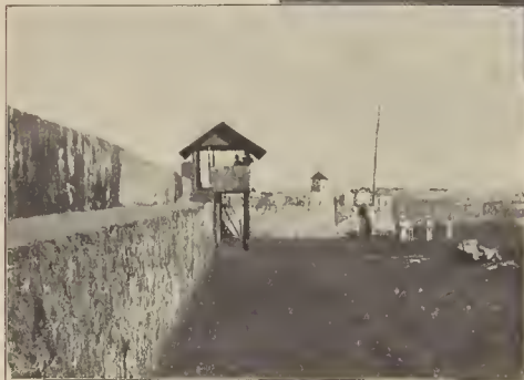
COLONIA DE PONAPÉ. — Vista del pequeño fuerte, depósito de cartuchería, adosado á la muralla que rodea la colonia
