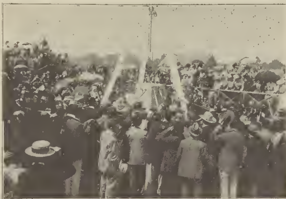
VIAJE DE SS. MM. Y AA. — GIJÓN. — Colocación de la primera piedra del Cuartel de Alfonso XIII (de fotografía de D. Ricardo del Río, Gijón).
