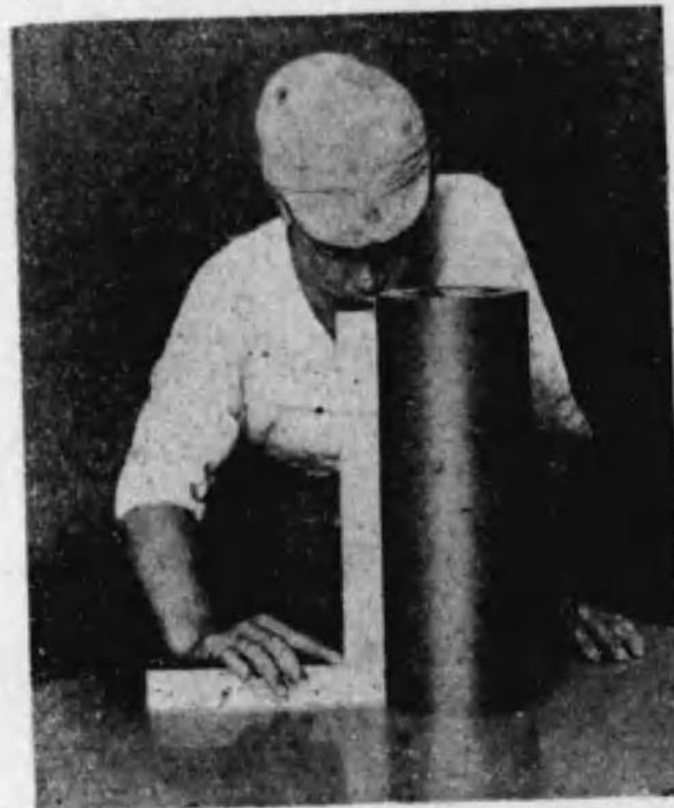
第135圖 圓柱にて定規を検査してゐる圖
