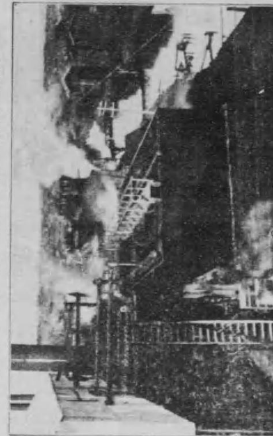
3. 蒸溜釜 (原油を右方に並べる釜に入れて氣化せしむ) (原注を右方に並べる釜に入れて氣化せしむ)
