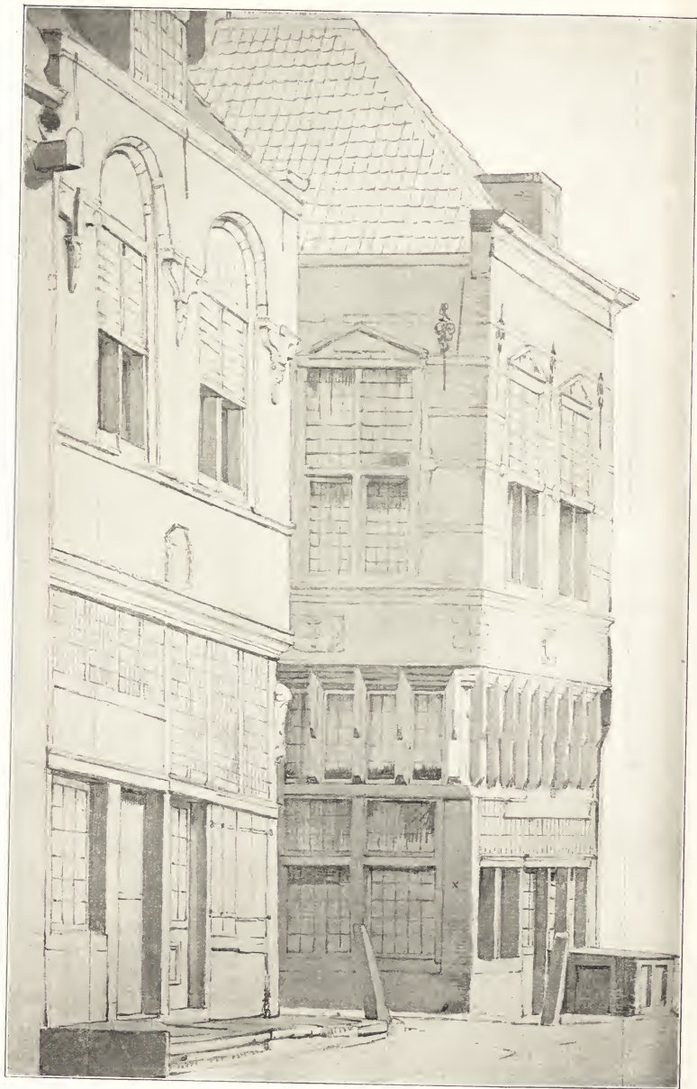
Afb. N o . 92. Oude gevels met houten onderpuien te Dordrecht. Naar eene teekening van J. Rutten, in de collectie van Mr. S. van Gijn.
