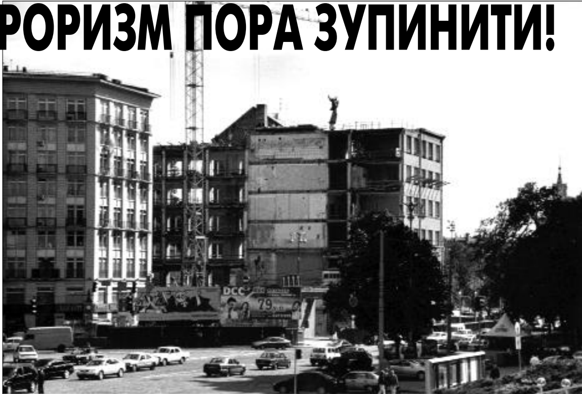
Руйнування за ініціатив С. Бабушкіна історичної будівлі стилю конструктивізму по вул. Хрещатик, 5 для будівництва на цьому місці хмарочоса
