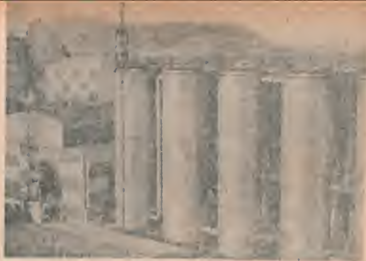
Unidade de ácido nítrico; utiliza como matéria-prima a amônia. Unidade de ácido nítrico; utiliza como matéria-prima a amônia e o ar. Tem uma capacidade de produção igual a 348 t/dia de ácido nítrico a 52%.
