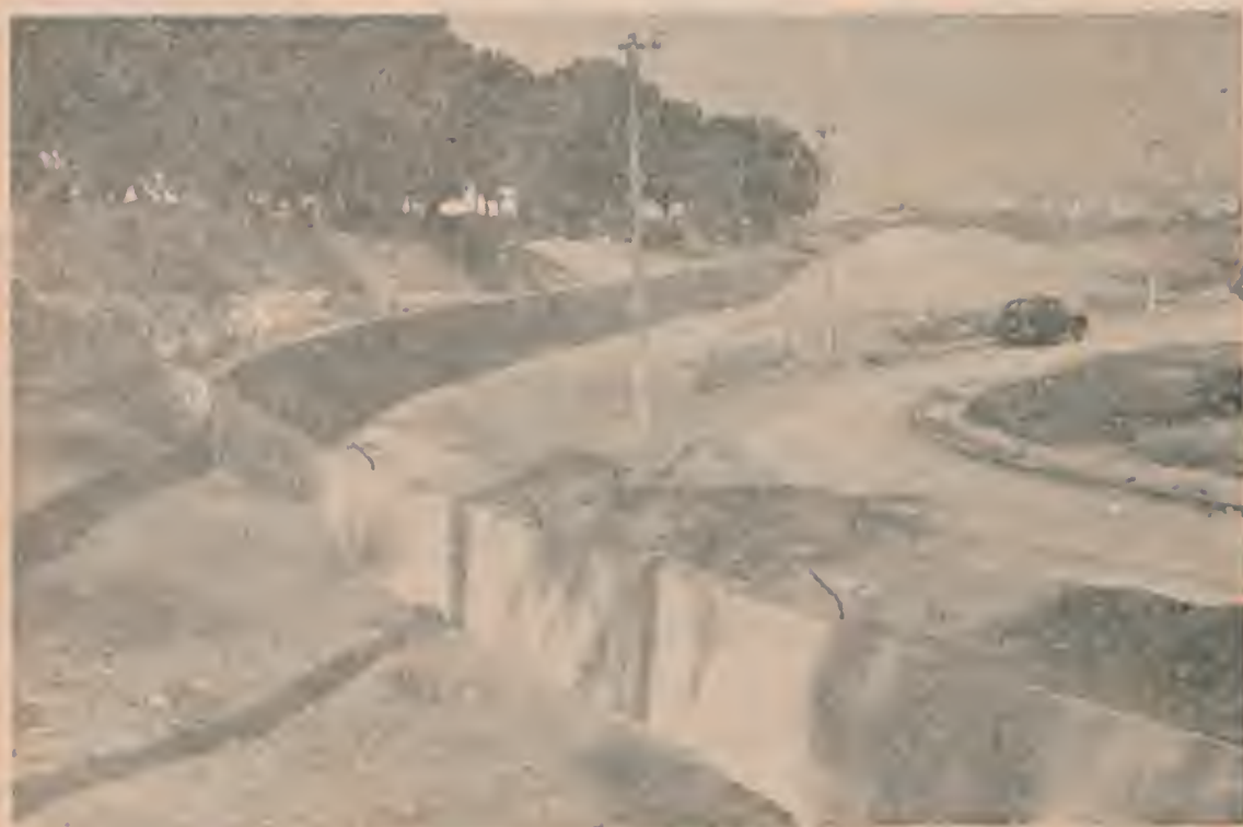
Em baixo, a mesma, trecho, após a construção do muro (fotos 1 e 2)
