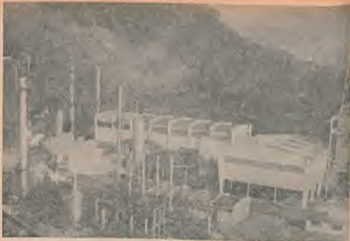
Unidade de amônia: Utiliza como matéria-prima o gás residual da Refinaria Presidente Bernardes e o ar atmosférico. A sua capacidade de produção é de 90 t/dia de amônia.
