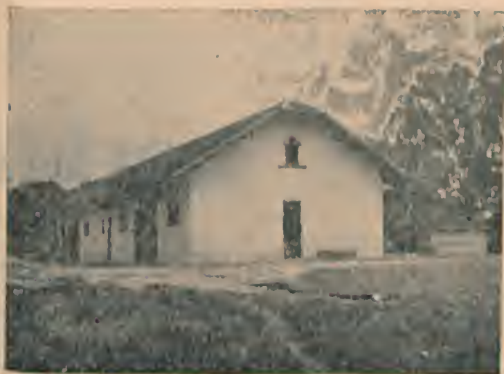
EHVB-Oficina Rural (240m2). Aspecto externo
