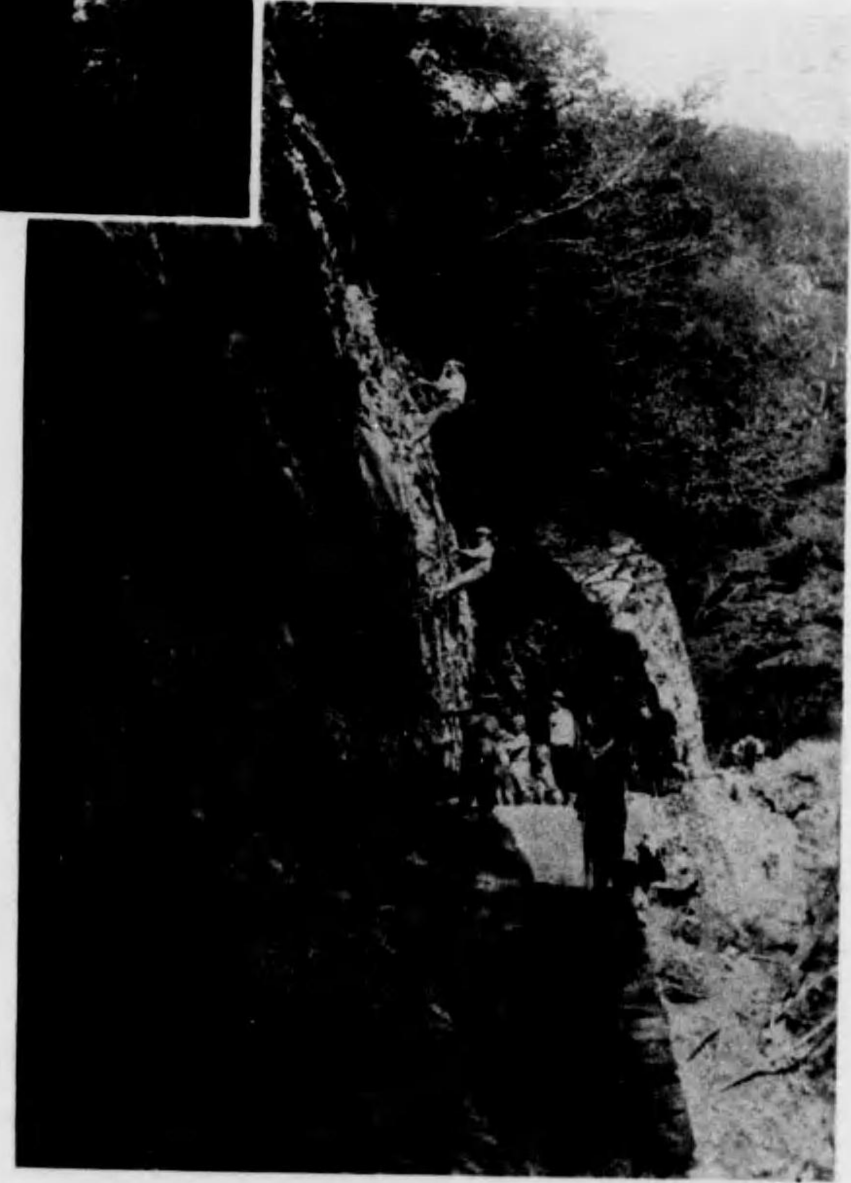
林道開墾工事
