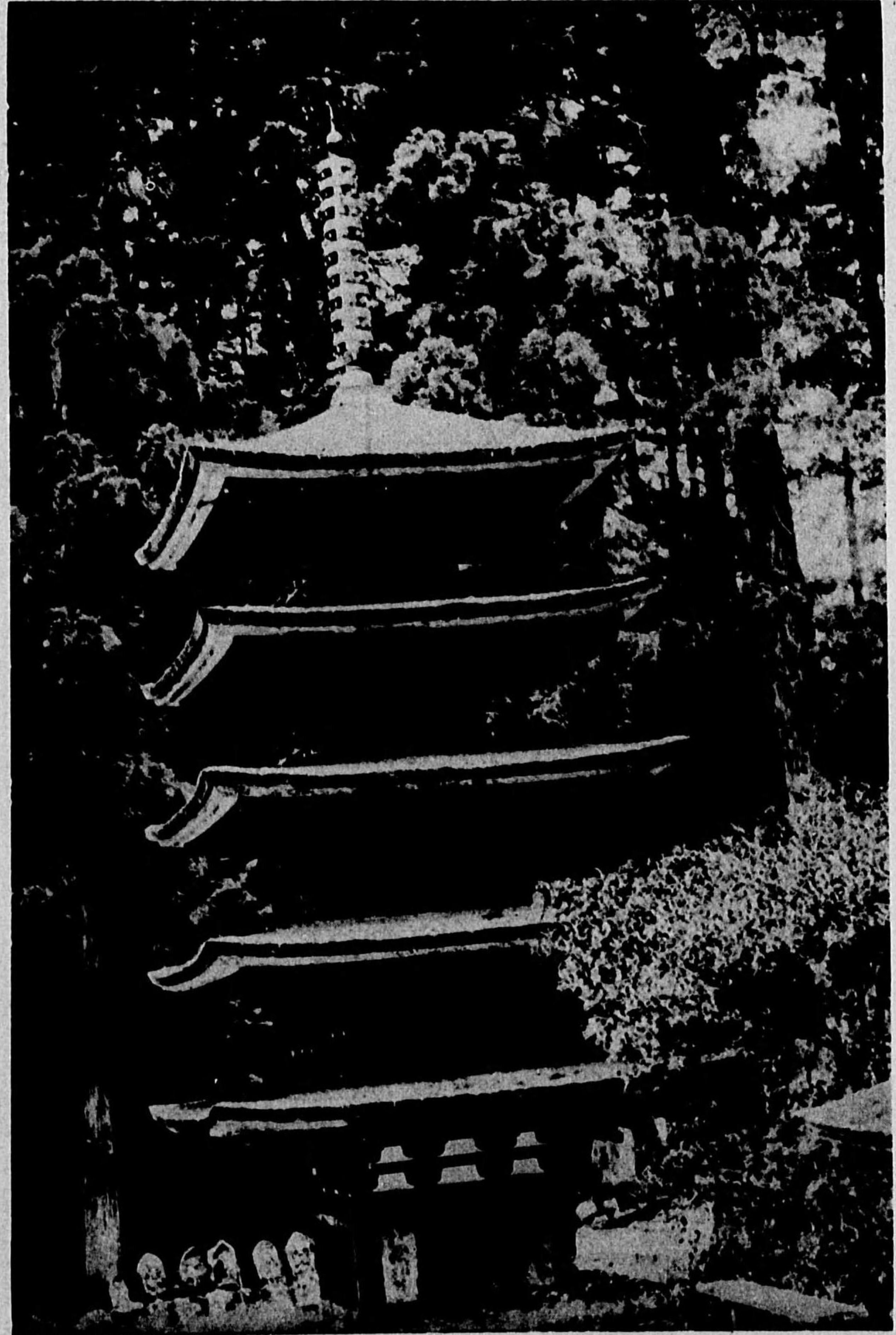
圖版一二 室生寺五重塔
