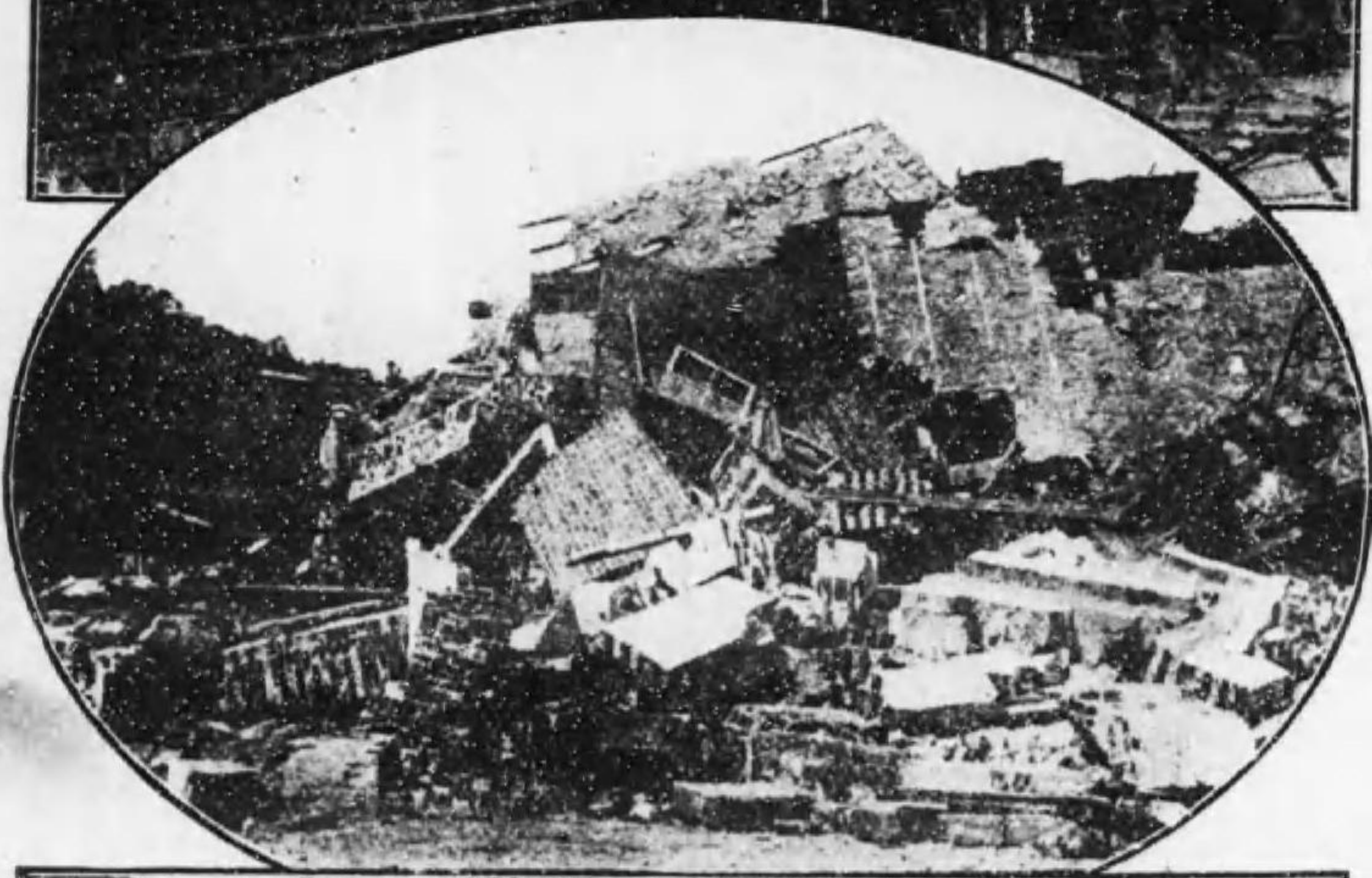
横須賀軍港糧食倉庫崩壊
