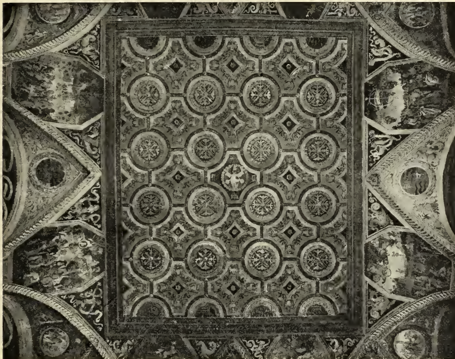
Abb. 70. Deckendekoration im Saal der Sibyllen. Rom. Appartamento Borgia.
