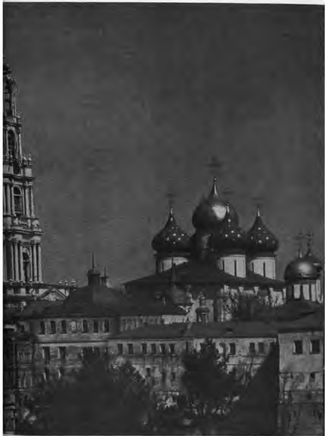
Панорама центральной части монастыря. Вид с запада слева направо: Колокольня, Келарские башни, Успенский собор, Троицкий собор, Духовская церковь, Пивная башня.
