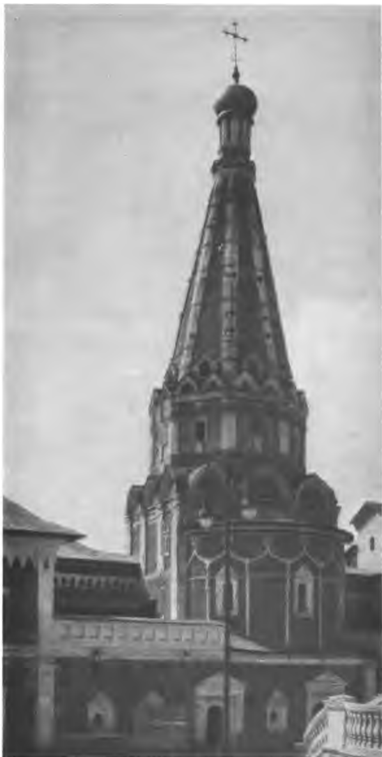
Церковь Зосимы и Савватия. 1635—1638. Восточный фасад
