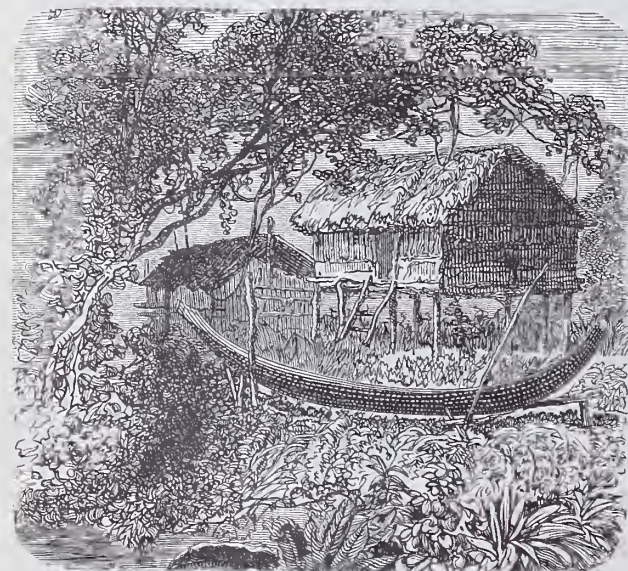
Fig. 2836. Bauerhütten in Kambodsche. Zu Art. Pfahlbauten.
