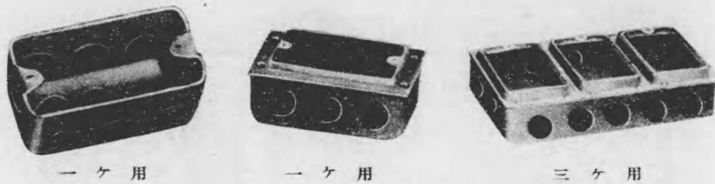
第15圖 埋込型スイッチボックス
