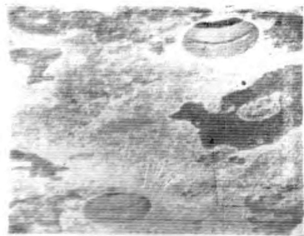
第六圖 爐板螺釘孔中裂開成層次形狀
