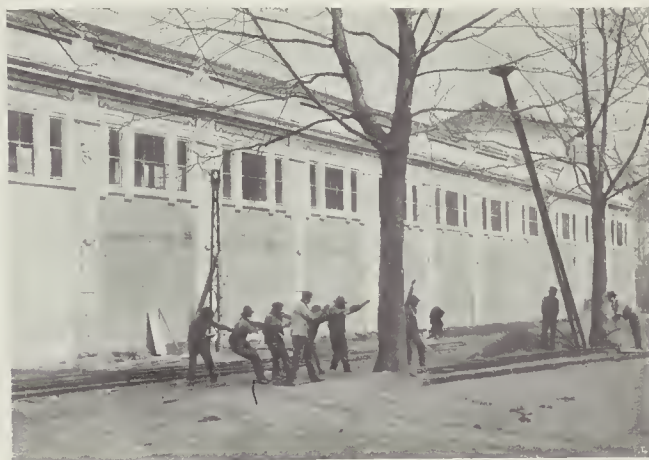
LAVORI PER L'IMPIANTO DELLA LUCE ELETTRICA AL PARCO.
