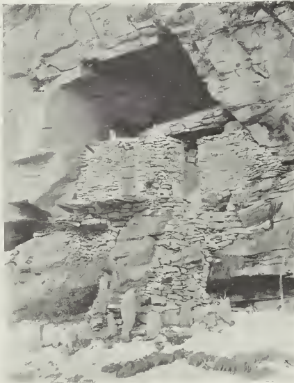
CAVERNA NATURALE TRASFORMATA IN CASA OPERAIA.
