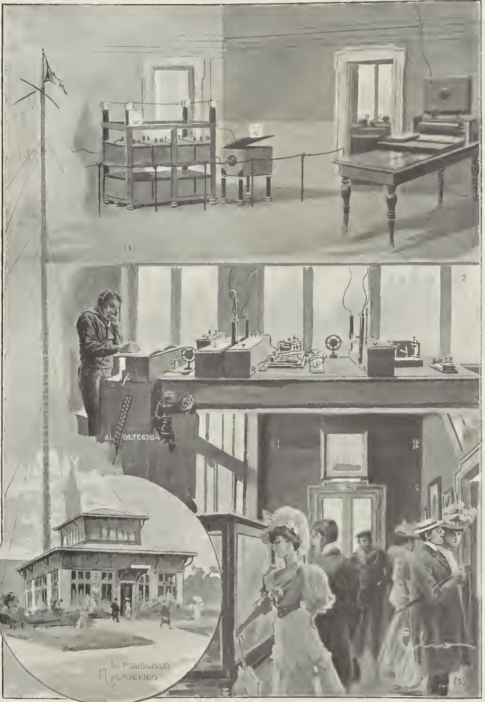
1. Sala centrale dove sono sistemate le due stazioni trasmettenti, una con Venezia ed Ancona l'altra colla Piazza d'Armi. — 2. Sala laterale ove sono sistemati gli apparecchi riceventi e dove funziona il personale di servizio. — 3. Una delle sale laterali ove sono raccolti gli apparecchi dai primi ideati dal Marconi ai più perfezionati.
