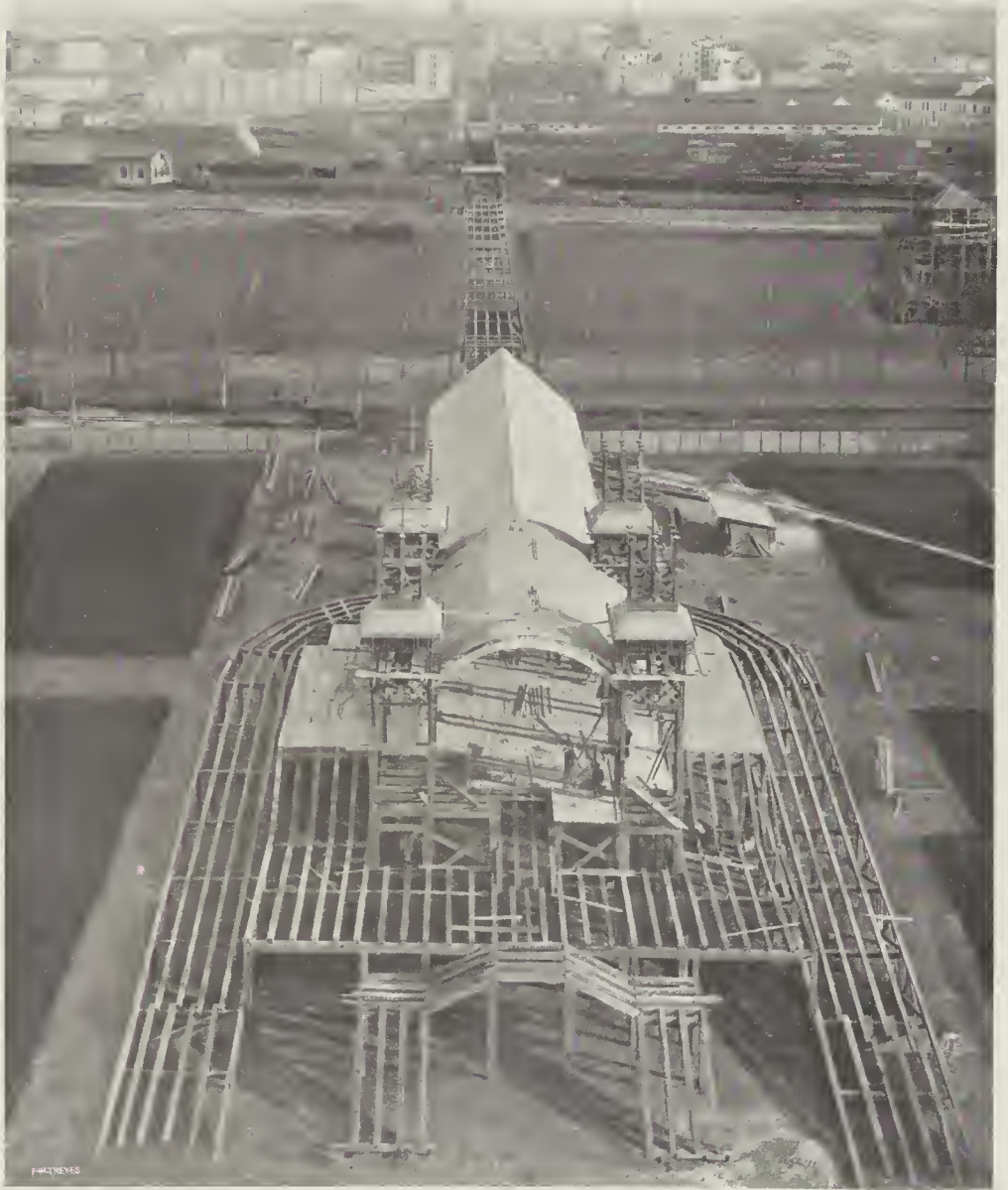
LA STAZIONE D'ARRIVO IN PIAZZA D'ARMI E IL VIADOTTO VEDUTI DAL FARO (fot. Allier-Lacroix).
