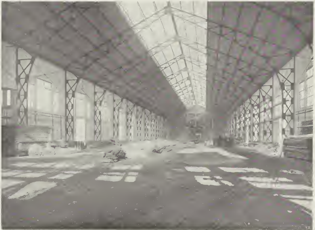
I LAVORI IN PIAZZA D'ARMI. — Interno della galleria centrale, in ferro, della Galleria del Lavoro (fot. Alfieri-Lacroix).
