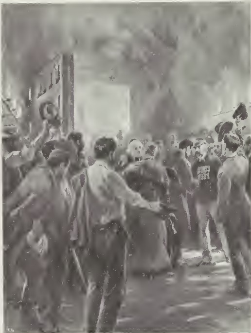
I LAVORI DELLA GALLERIA DEL SEMPIONE. — Alle porte di ferro.
