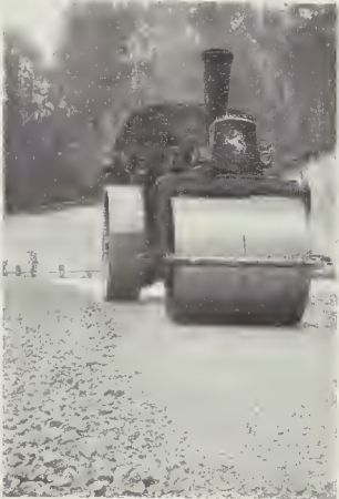
RULLO COMPRESSORE A VAPORE IN FUNZIONE.
