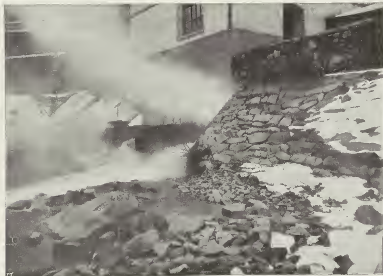
I LAVORI DEL SEMPIONE. — La colonna d'acqua termale sgorga presso l'imboccatura della galleria d'Iselle. (Fot. Treves).
