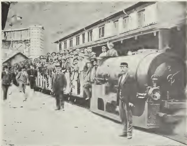
I LAVORI DELLA GALLERIA DEL SEMPIONE. — Il treno con gli operai che fecero cadere l'ultimo diaframma. (Fotografia Treves).
