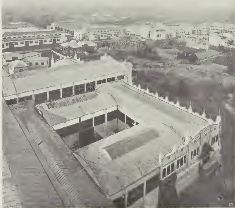
I LAVORI IN PIAZZA D'ARMI. — Una parte dell'Esposizione veduta dal Faro (fot. Alberti-Lacret).
