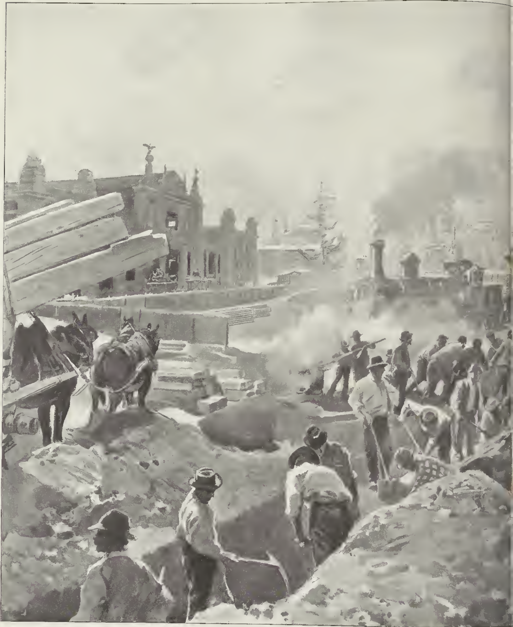
I LAVORI IN PIAZZA D'ARMI
