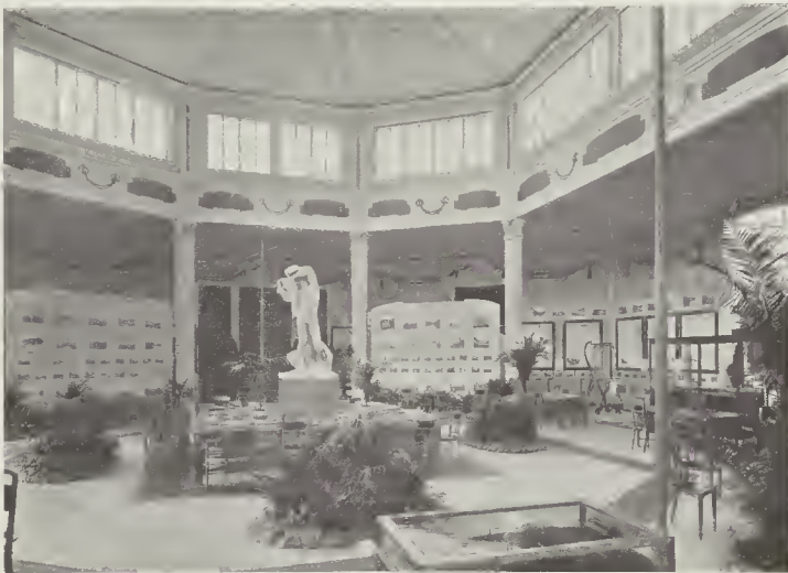
OTTAGONO CENTRALE DEL PADIGLIONE DELLE FERROVIE DELLO STATO (dot. A. Ferrario).
