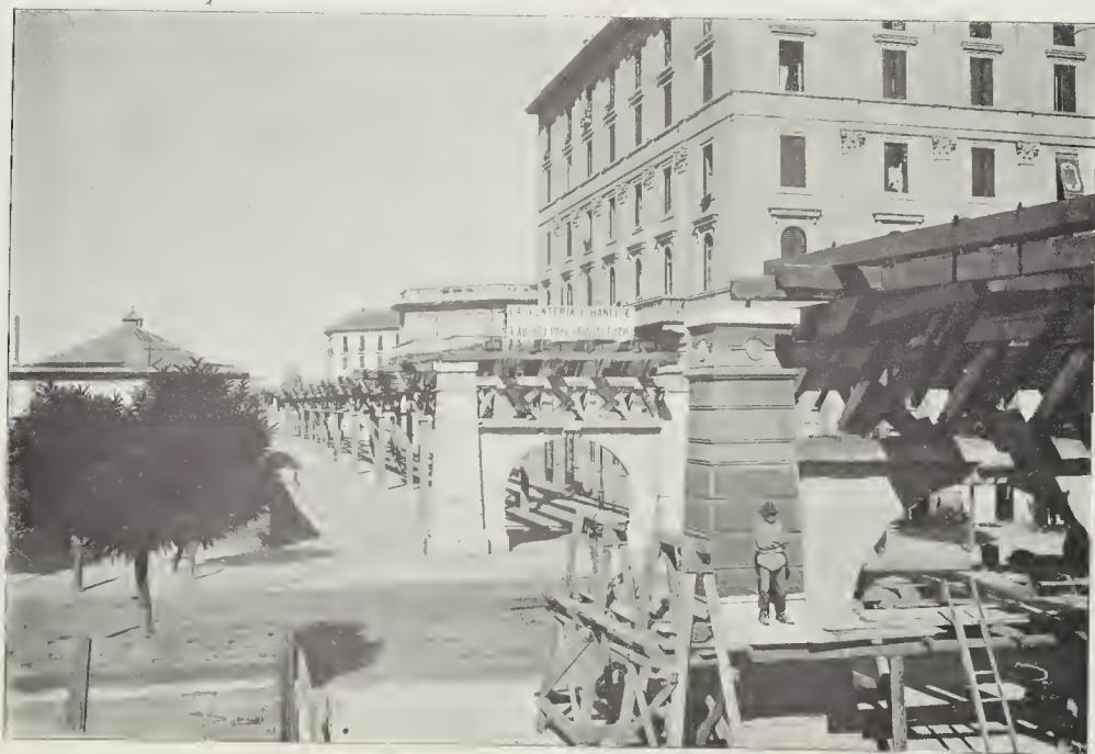
Stato attuale dei lavori. — Il viadotto fra il Parco e la Piazza d'Armi.
