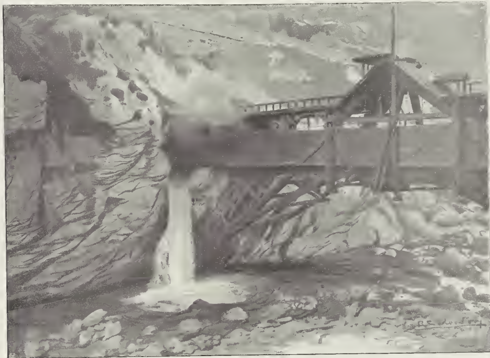
Ingresso alla linea retta; Bocca di scarico dell'acqua fredda sgorgante nella galleria.
