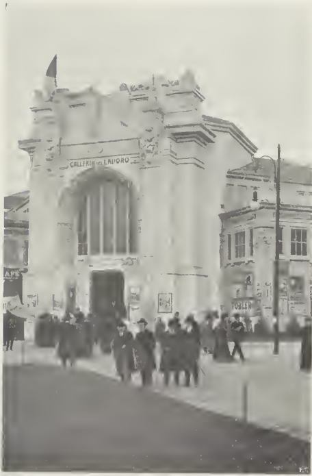
Prospetto ovest della Galleria del Lavoro.
