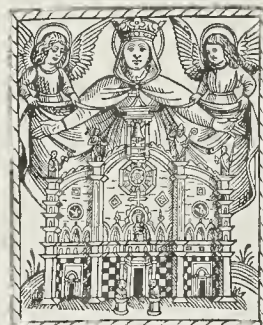
Facciata posticcia primitiva del Duomo.
