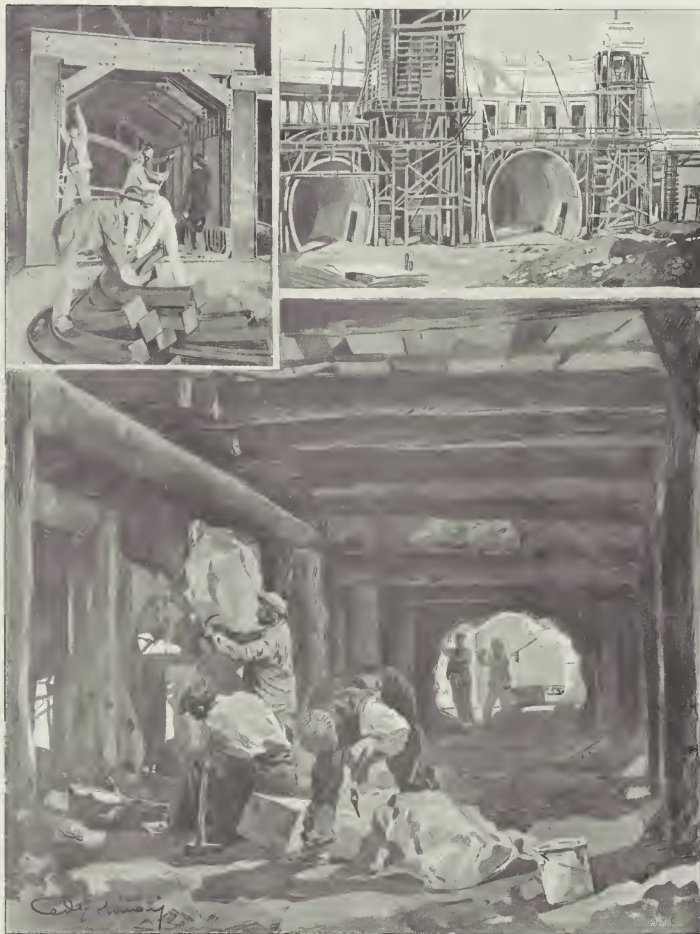
L'ingresso alle gallerie. — I lavori nell'interno.
