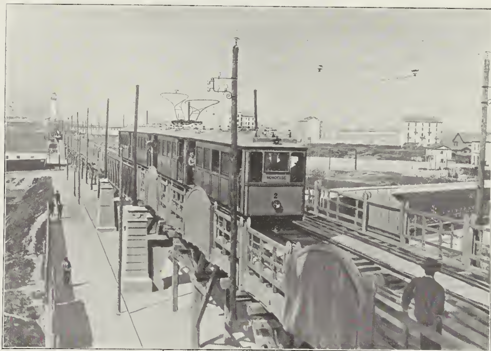
IL TRENO DI PROVA SUL VIADOTTO (fotografia di Elio).
