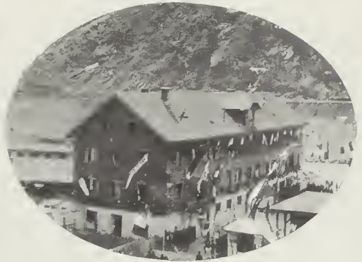
Il cantiere d'Iselle il giorno dell'inaugurazione.
