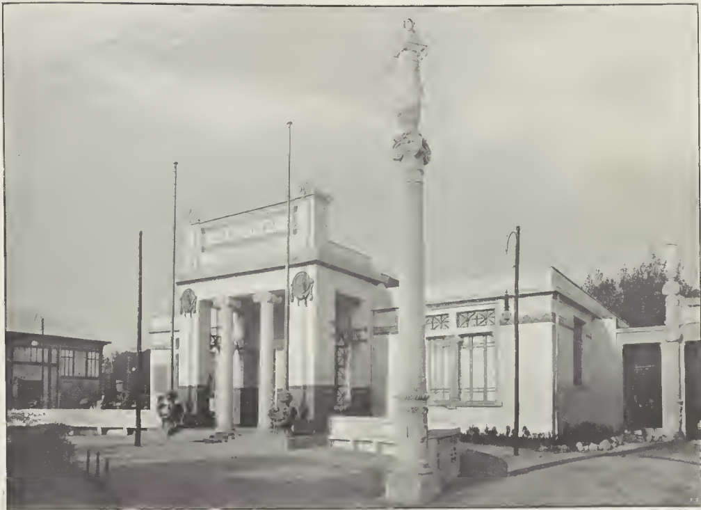
IL NUOVO PALAZZO DELL'ARCHITETTURA.
