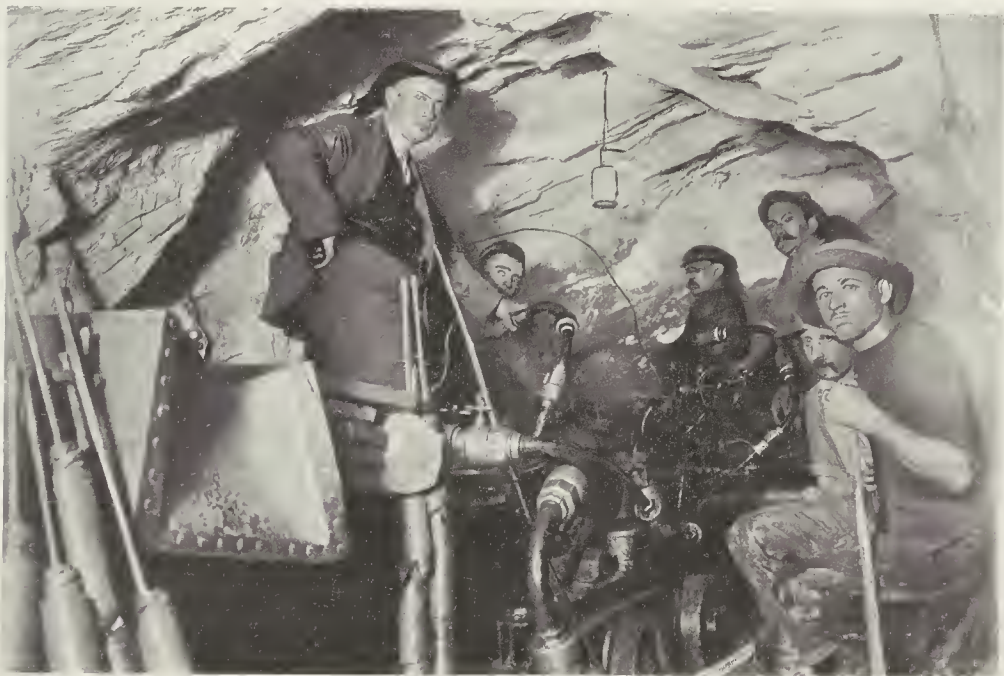
LA GALLERIA DEL SEMPIONE. — Dopo la chiusura di una vena d'acqua: ricomincia il lavoro delle perforatrici (fot. J. Endrich, di Zurigo).
