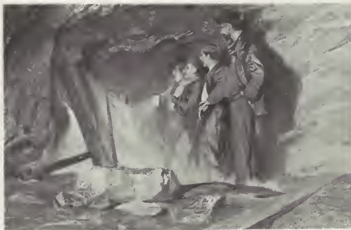
I LAVORI DELLA GALLERIA DEL SEMPIONE. — L'ultima breccia (fot. Calzolari e Ferrario).
