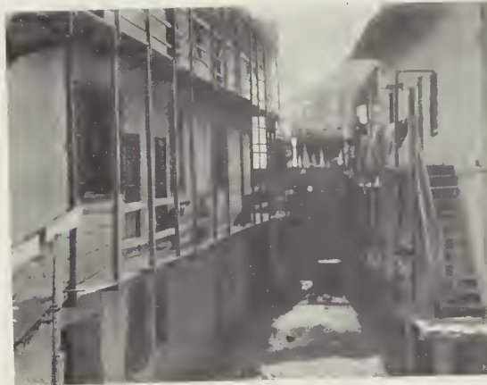
CASE IN LEGNO ERETTE DAGLI OPERAI
