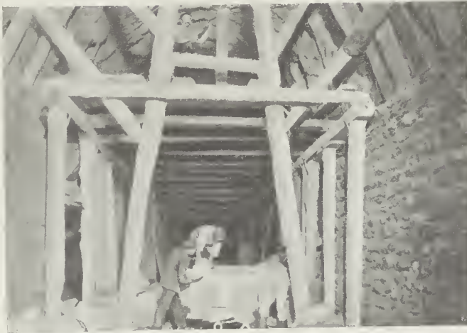
I LAVORI DELLA GALLERIA DEL SEMPIONE. — Impalcatura interna.
