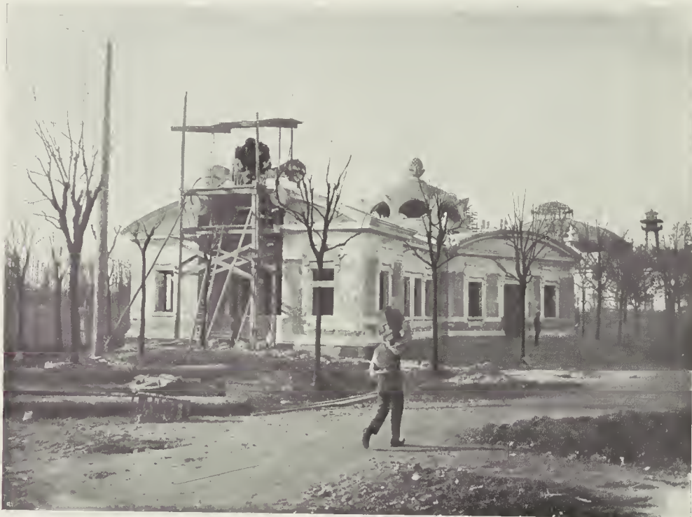
I LAVORI AL PARCO. — Il Padiglione per la Stampa, Poste e Telegrafi (fot. Varischi, Artico e C.).
