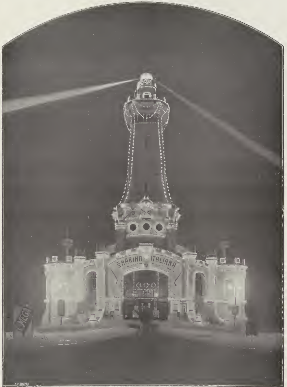
EFFETTO DELL'ILLUMINAZIONE DEL FARO E DEL PADIGLIONE DELLA MARINA.
