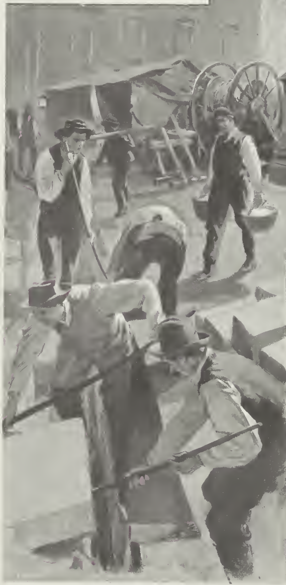
MILANO SI PREPARA PER L'ESPOSIZIONE. -- La pavimentazione in granito delle vie. (Disegno di U. Salvadori).
