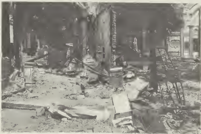
LA MOSTRA UNGERESE DOPO L'INCENDIO DEL 3 AGOSTO (fot. di R. Salvadori).
