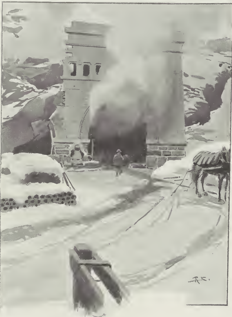
I LAVORI DELLA GALLERIA DEL SEMPIONE. — Portale della galleria a Iselle, sul versante italiano.
