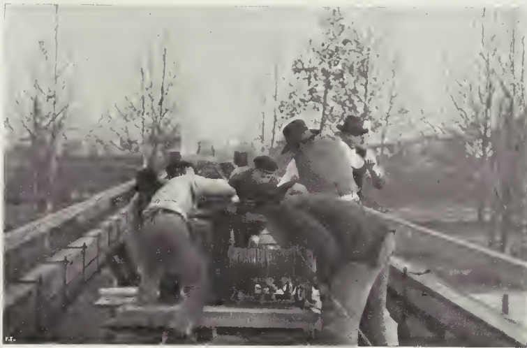
I LAVORI PER L'IMPIANTO DEL VIADOTTO (fot. Varschi, Artico e C.).
