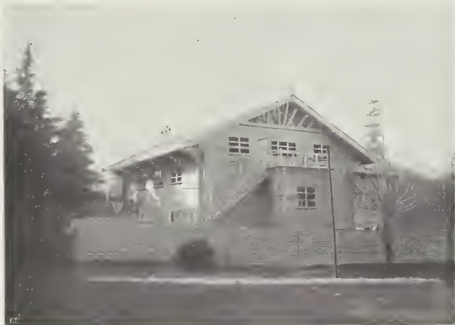
CHALET-CINEMATOGRAFO DELLA GALLERIA DEL SEMPIONE (fot. Varisch, Artico e C., Milano).
