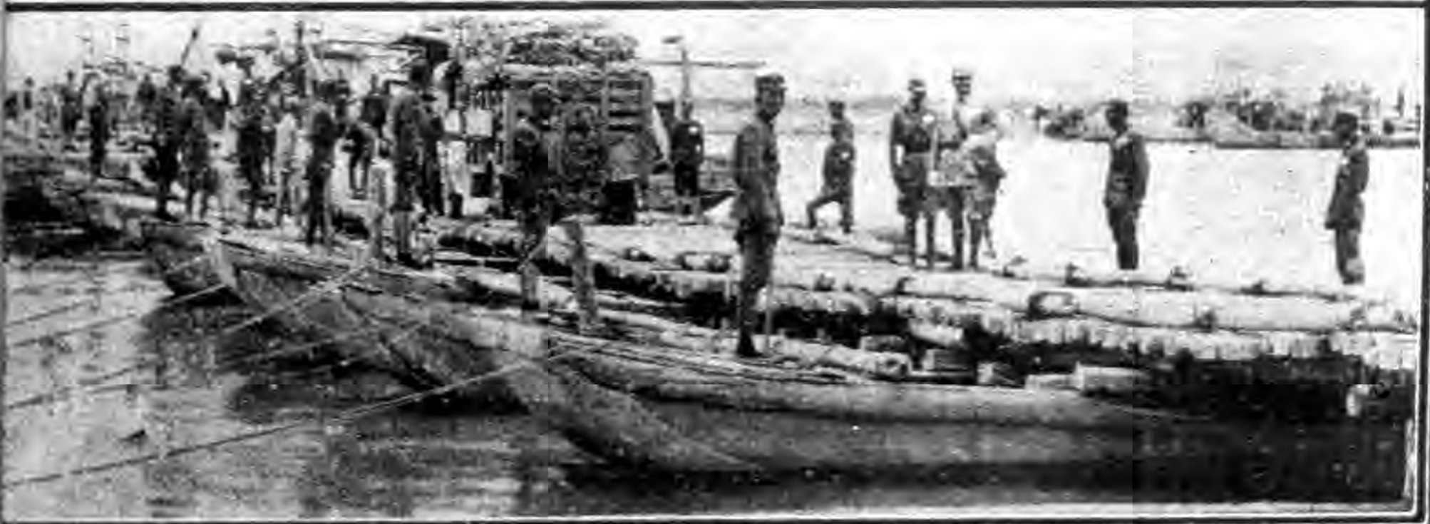
部隊通過之完架橋由重載汽車由架完之橋通過
