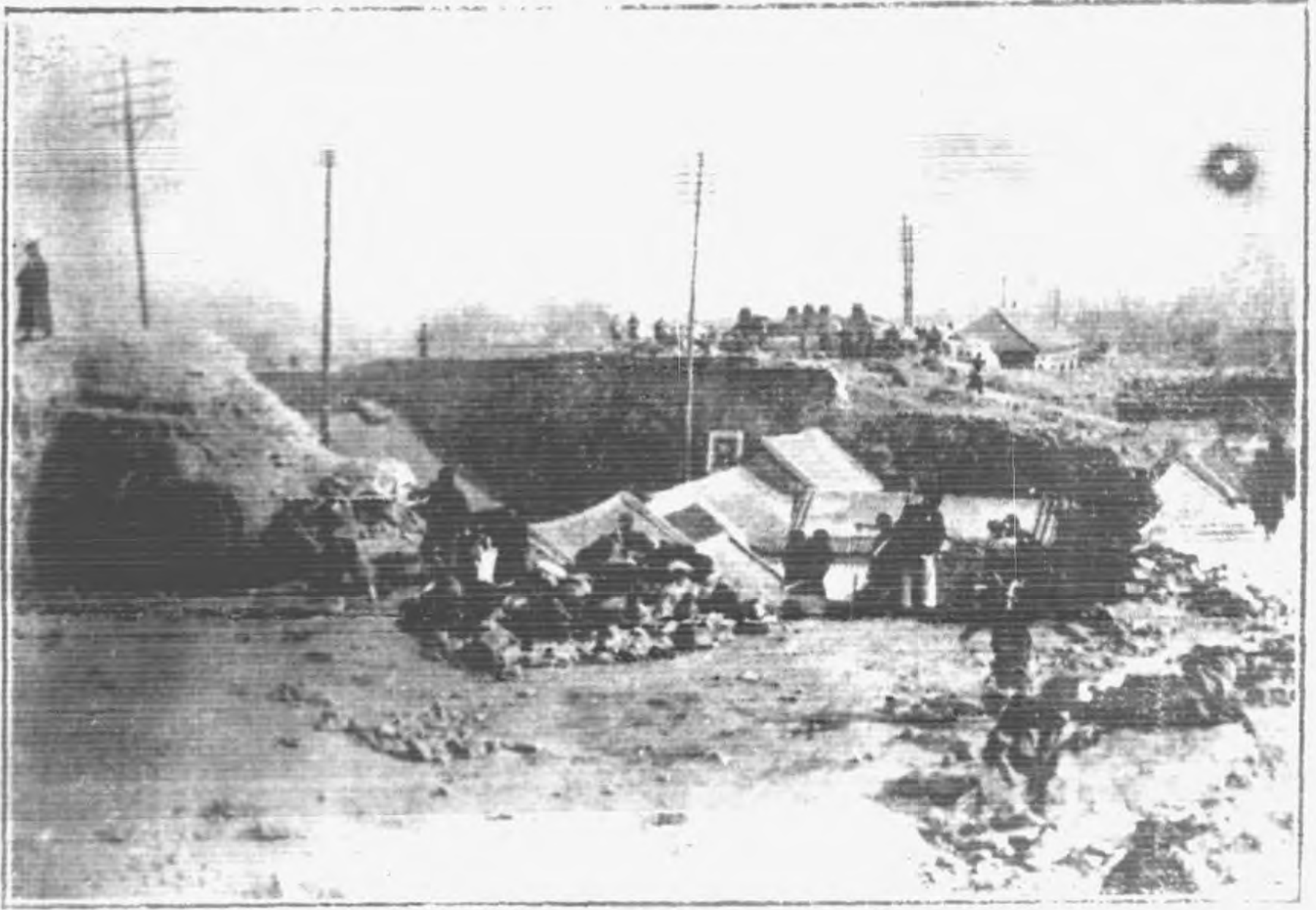
(七) 災民丁拆除舊東門工作情形
