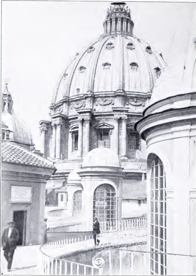
Abb. 91. Blick über einen Teil des Daches der Peterkirche mit der großen Hauptkuppel und vielen kleineren Kuppeln (den Eingängen der Treppen). (Zu Seite 137.)
