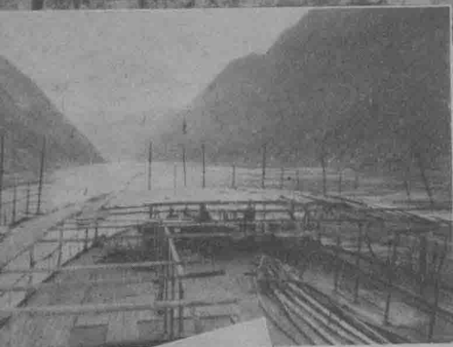
← 江建輪甲板施工情形
