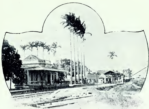
Estação de S. Christovão
