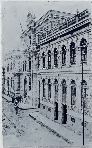
Corpo de Bombeiros (fachada da rua do Senado)
