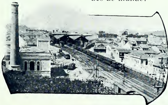
Interior da estação
