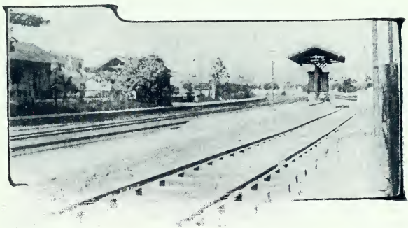
Estação da Mangueira
