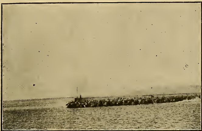
Salina Cruz.—Enrocamientos, parapeto y faro del dique del Oeste.
