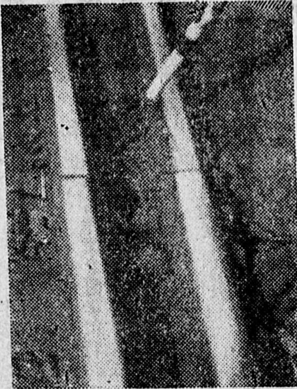
第二十二圖 この床飯はずれ出すことが多い(ずれ出すと隣接床飯に觸れて短絡する)
