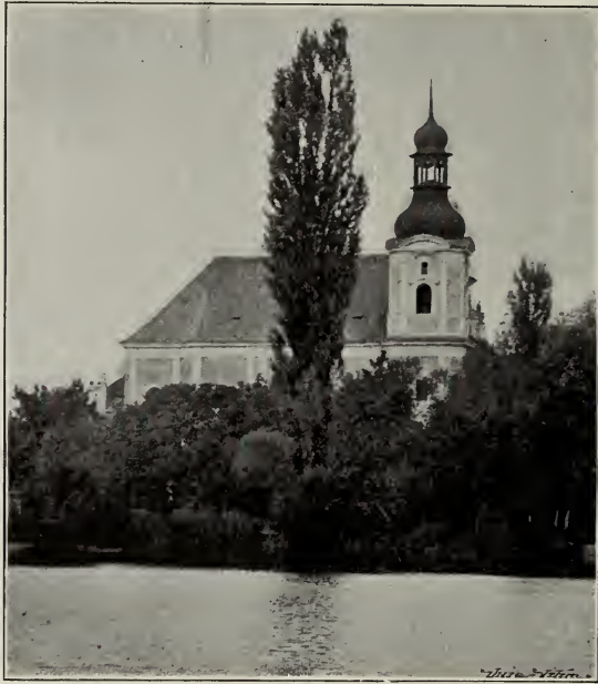
Fig. 104. Woborisch. Die Kirche. (Südseite.)
