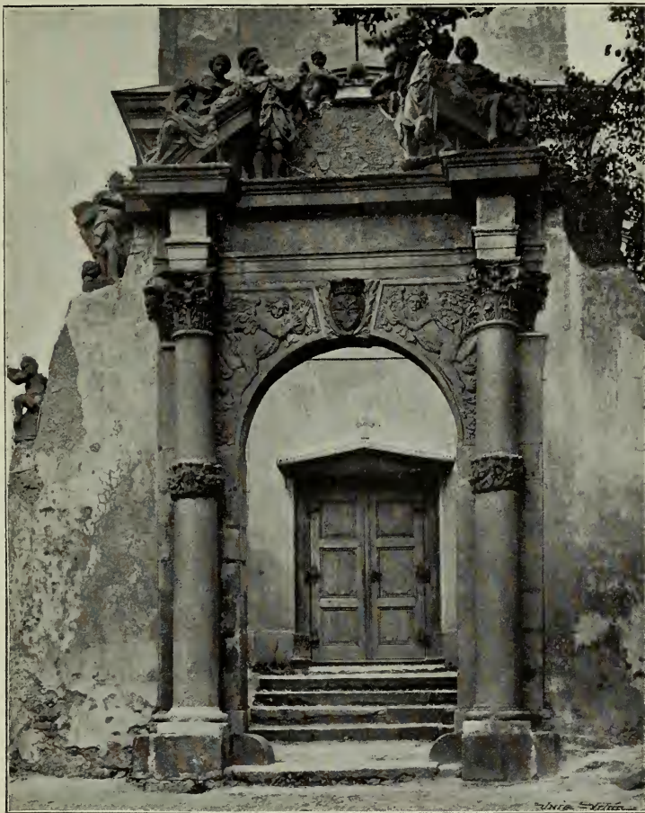
Fig. 122. Pitschin. Portal in der Kirchhofsmauer.
