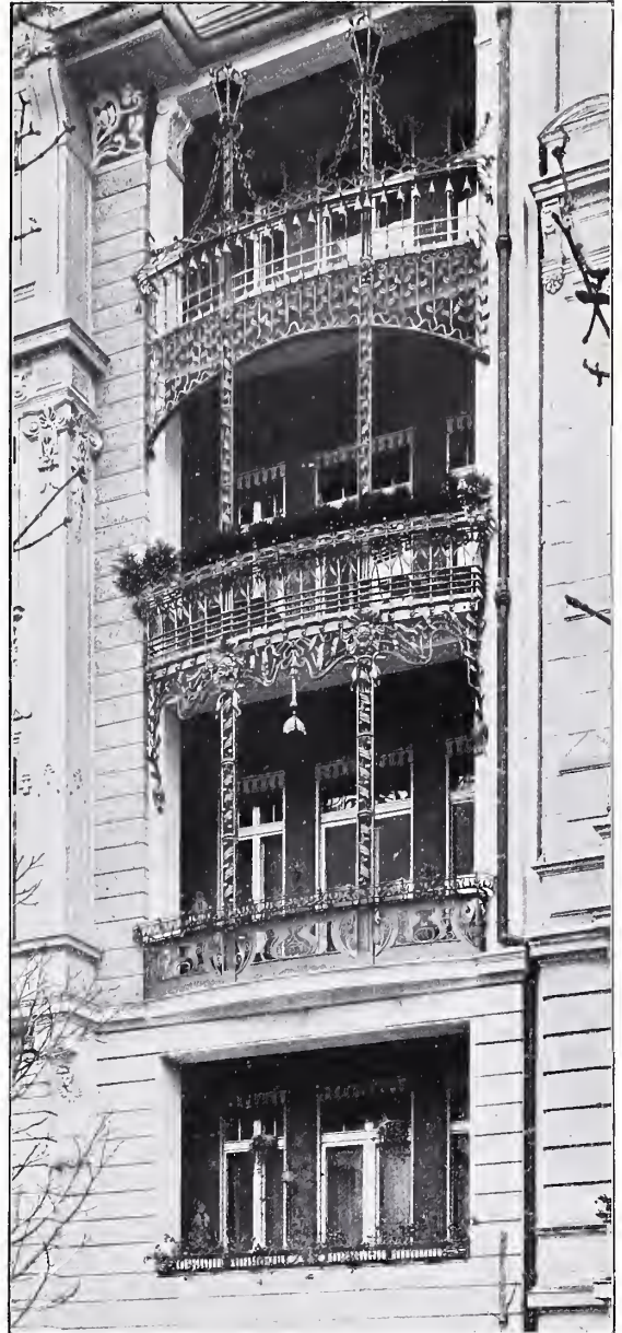
Balkonausbildung am Wohnhause Fasanenstrasse 97. Nach dem Entwurfe von PAUL LINGNER, Architekt in Charlottenburg, ausgeführt von ROB. BLUME, Kunstschlosser in Charlottenburg.
