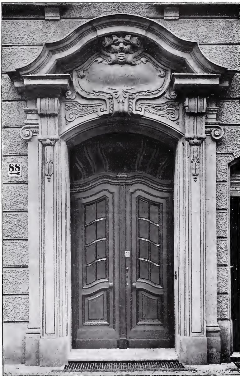
Portal Kurfürstenstrasse 88. Architekten: HART &amp; LESSER in Berlin.
