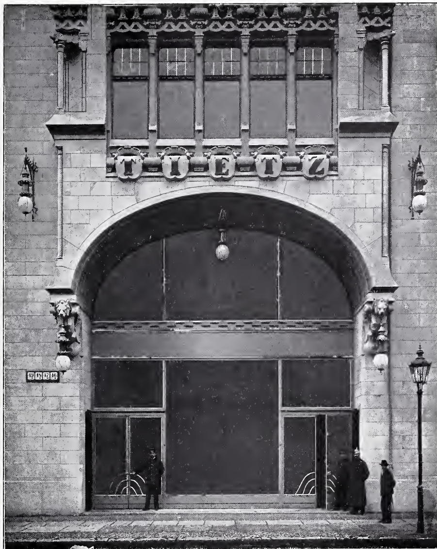
Kaufhaus Tietz. Haupteingang in der Krausenstrasse. Architekten: B. SEHRING in Charlottenburg und L. LACHMANN in Berlin.
