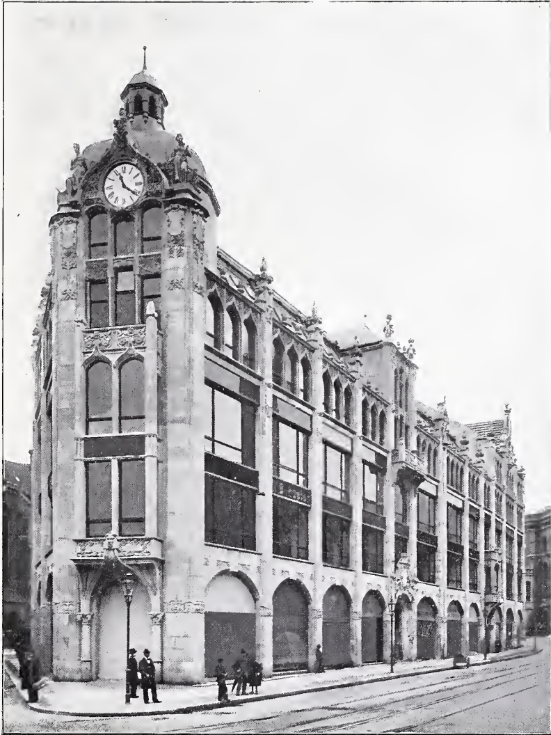
Kaufhäusergruppe an der Spandauerstrasse, Ecke Nicolai-Kirchhof. Erbaut von HOENIGER & SEDELMEIER, Architekten in Berlin.
