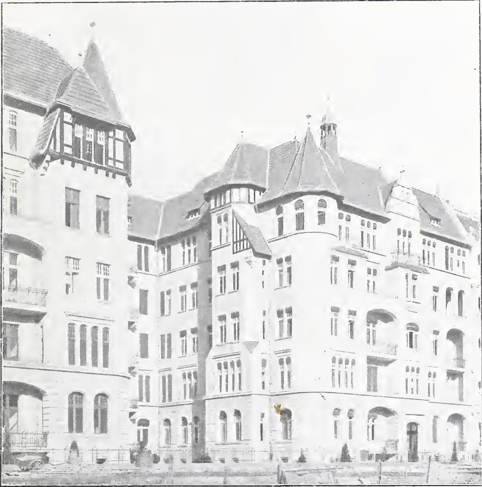
Wohnhaus Luitpoldstrasse 20 und 21. Architekt: PAUL JATZOW in Berlin.
