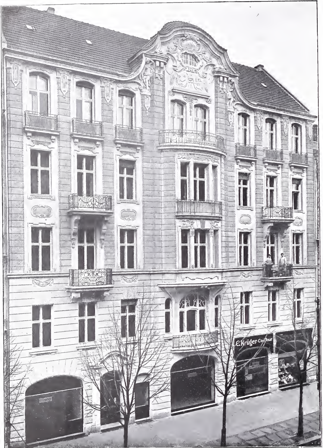
Geschäfts- und Wohnhaus Kurfürstenstrasse 88. Architekten: HART & LESSER in Berlin.
