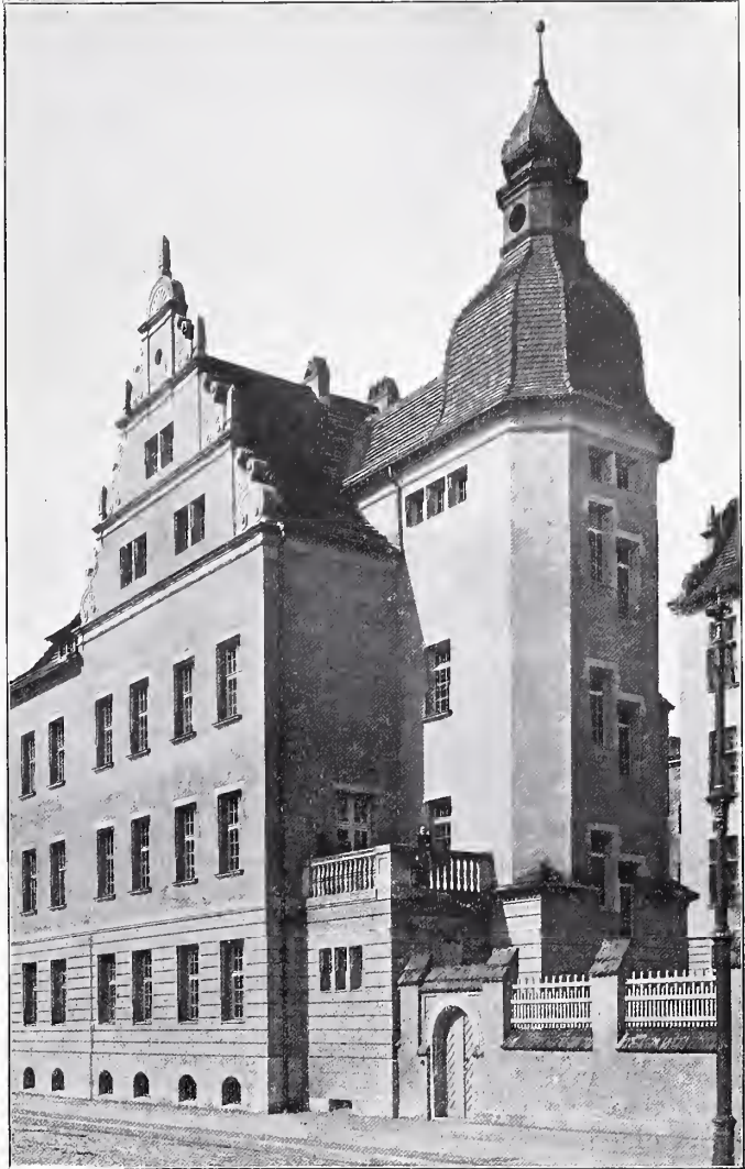
Gemeinde-Doppelschule in der Glogauerstrasse. Rektorenwohnhaus. LUDWIG HOFFMANN, Architekt in Berlin.
