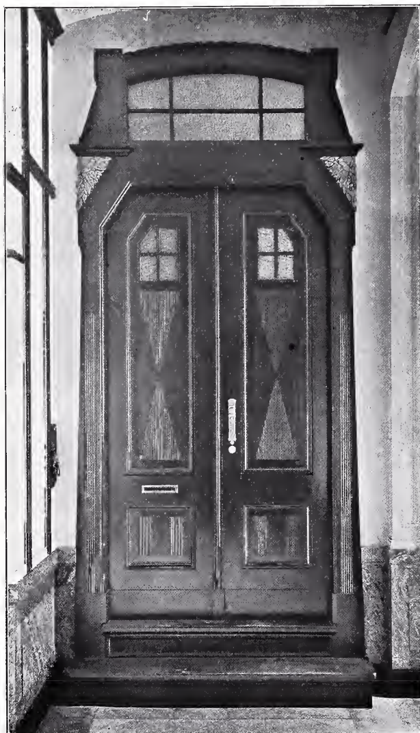
Korridorthür. Neue Bayreutherstrasse 12.
