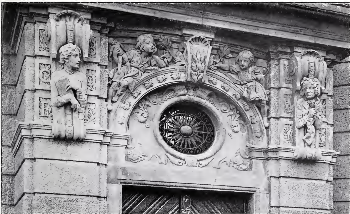
Neubau der Gemeinde-Doppelschule an der Wilms-Strasse. Detail des Portals der Mädchenschule. Architekt: LUDWIG HOFFMANN in Berlin.
