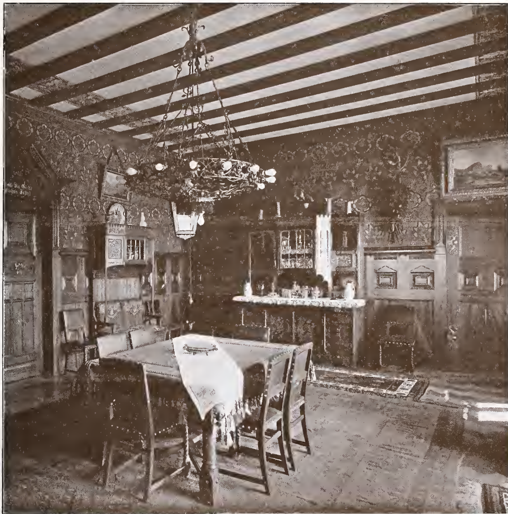
Speisezimmer in der Villa Knorr in Heilbronn. Architekten: J. VOLLMER &amp; H. JASSOY in Berlin.
