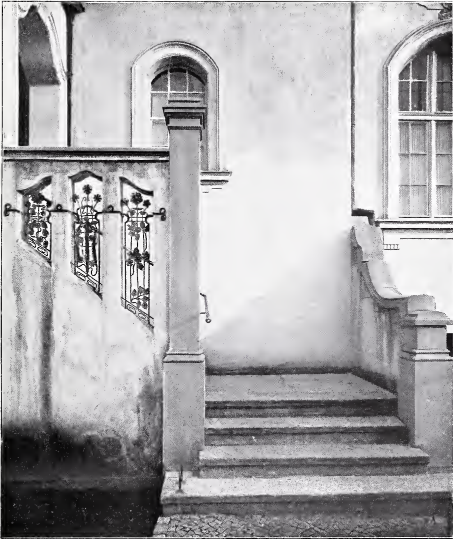
Landhaus Baumbach, Lietzenburgerstrasse 43 in Wilmersdorf. Architekten: SPALDING & GRENANDER in Berlin.
