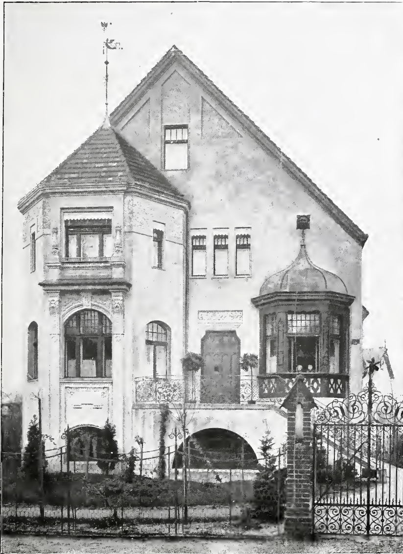
Villa Taubert in Zehlendorf, Alsenstrasse. Architekt: OTTO RIETH in Berlin.
