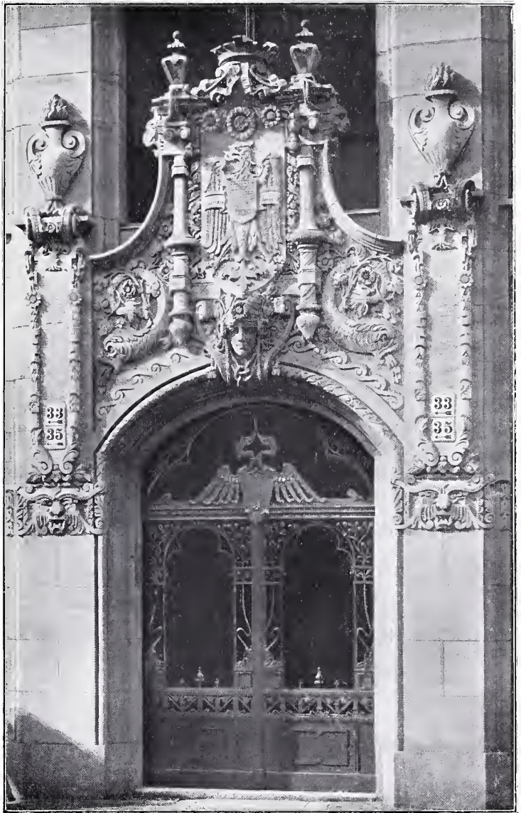
Portal an der Kaufhäusergruppe Spandauerstrasse 33—35. HOENIGER & SEDELMEIER, Architekten in Berlin.
