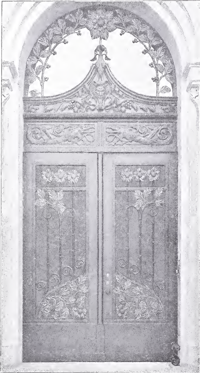
Eingangsthür in Schmiedeeisen am Wohnhause Pfalzburgerstrasse, Ecke Pariserstrasse. METHLING & GLEICHAUF, Kunstschmiede in Charlottenburg entworfen und ausgeführt.
