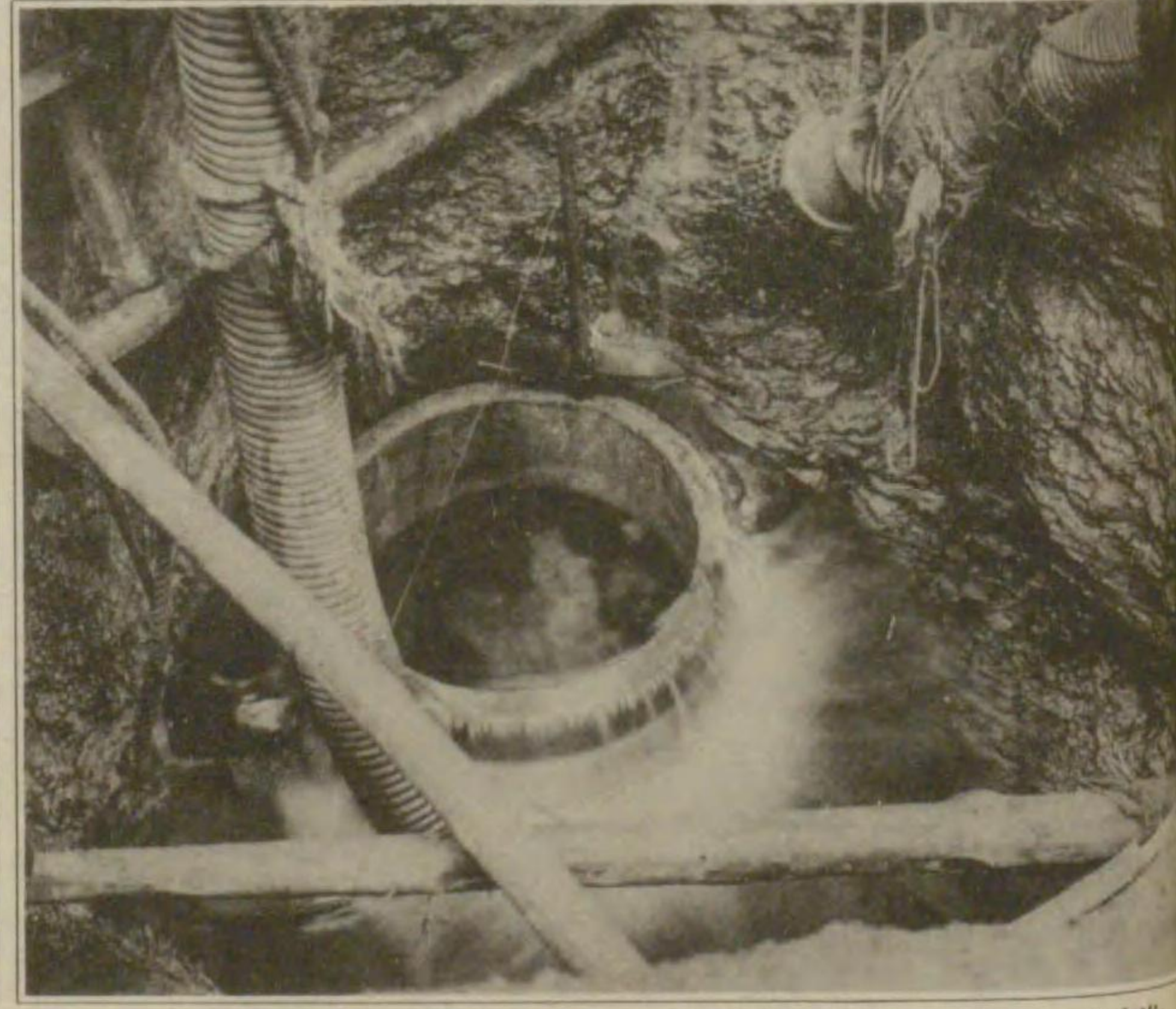
湧水口ヨリ湧水ヲ寫ス 湧水量一日約 4500 立方米
