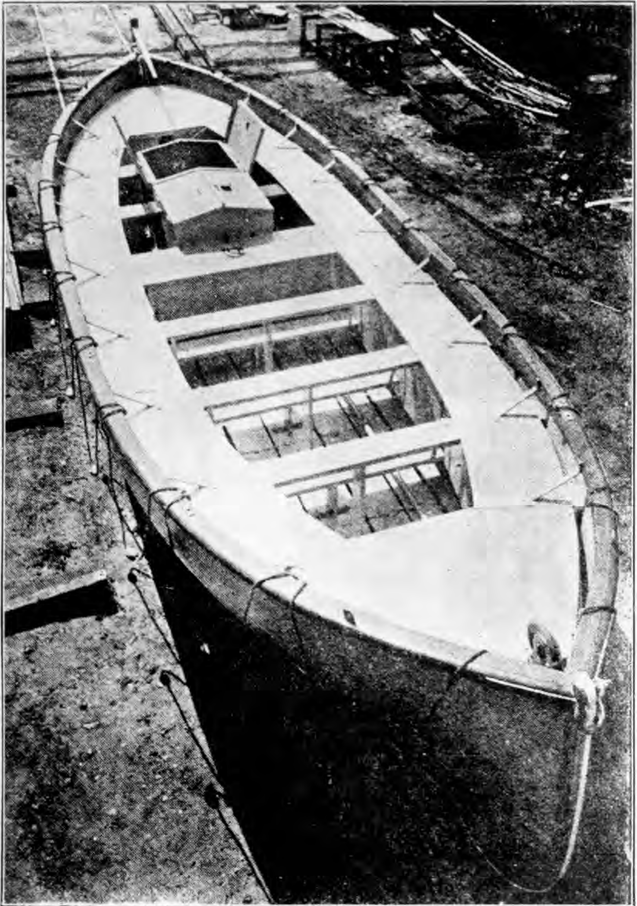
艇身構造採鑄接式長三十一呎九寸寬九呎三寸深九呎時裝載十四人
