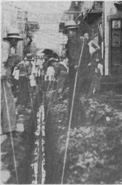
戊子牌設放 300 對地下鑊裝 電纜因街道狹小電纜笨重設 放時困難情形
