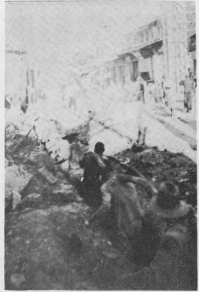
臬司前設放 300 對鑊裝地下 電纜兩條時情形
