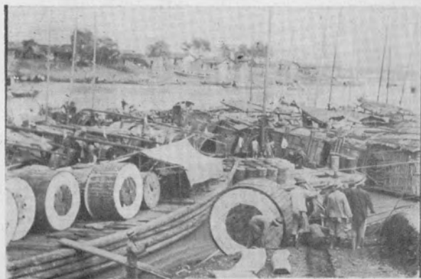
300 對鎧裝電纜向岸上運輸情形
