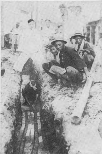
臬司前放竣 300 對地下電纜 後蓋置紅磚散放黃沙時情形
