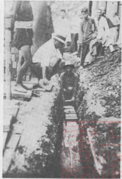
德勝路上已放竣之電纜正在 蓋置紅磚填放黃沙情形
