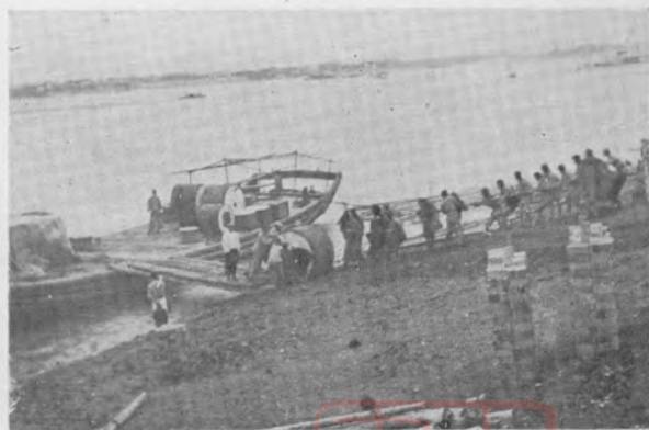
船上電纜向岸上運輸情形
