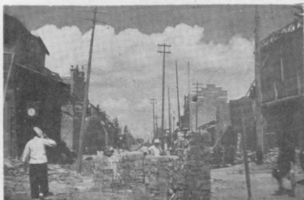
泉司前街放闊馬路正在興工拆屋時情形
