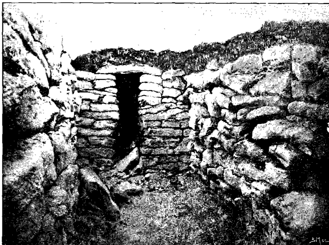
FIG. I. — RUINES DE KALDÁRSEL. (D'après une photographie de M. Daniel Bruun.)
