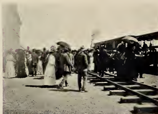
ASPECTO DE UNA ESTACION DE LAS OBRAS DE AGUAS POTABLES.
