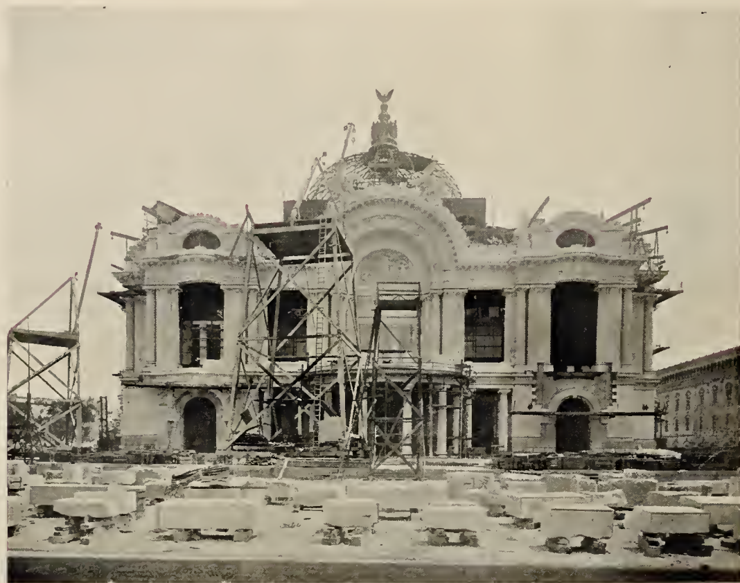
FACHADA PRINCIPAL DEL TEATRO NACIONAL (EN CONSTRUCCION).
