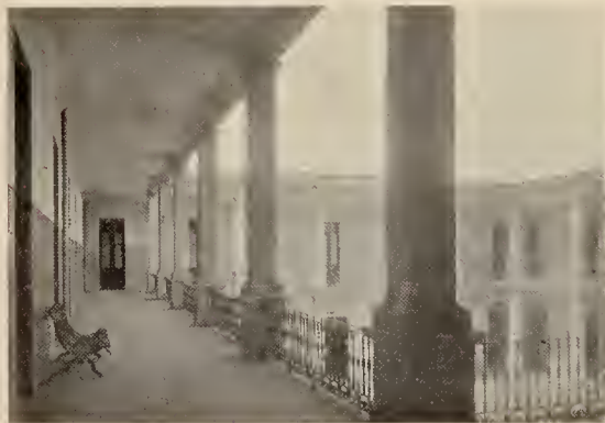
CORREDOR DEL PATIO PRINCIPAL DEL EDIFICIO DE SERVICIOS GENERALES EN EL MANICOMIO GENERAL.
