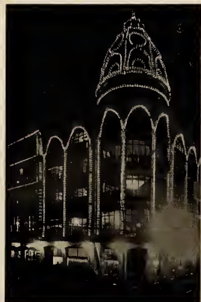
EL EDIFICIO DE «LAS FABRICAS UNIVERSALES» ILUMINADO.
