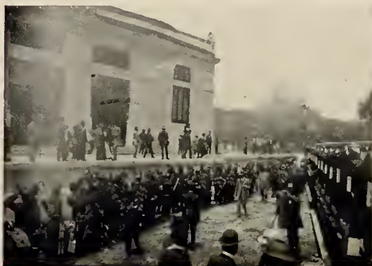
EL EDIFICIO DE LAS BOMBAS DE AGUAS POTABLES.
