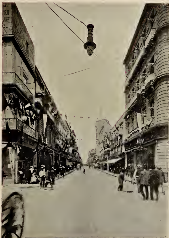
AVENIDA DE SAN FRANCISCO (ORIENTE A PONIENTE).
