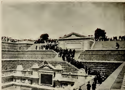
LOS INVITADOS RECORREN LAS OBRAS EXTERIORES DEL TUNEL DE TEQUIXQUAC.
