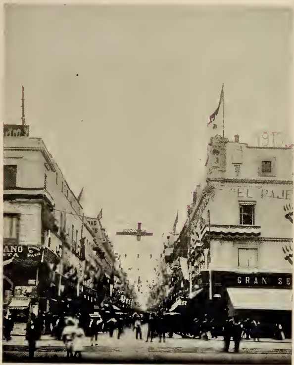
AVENIDA DE SAN FRANCISCO (ORIENTE A PONIENTE).
