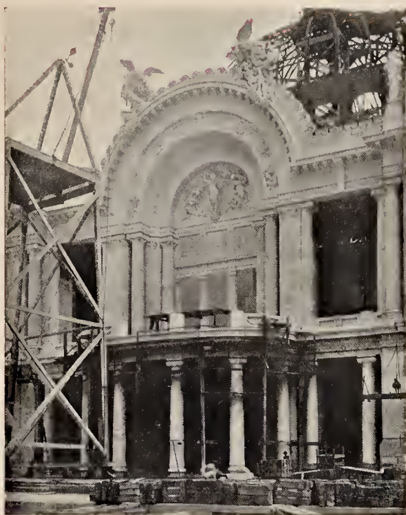
ENTRADA PRINCIPAL DEL TEATRO NACIONAL (EN CONSTRUCCION).
