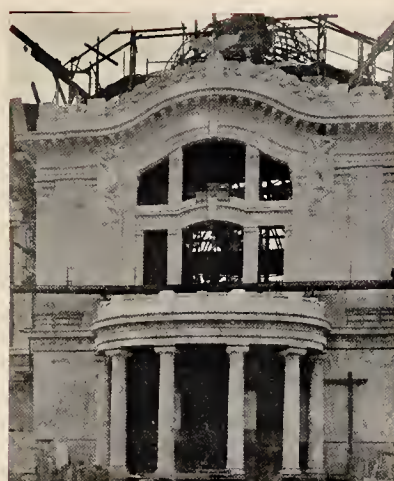
ENTRADA LATERAL DERECHA DEL TEATRO NACIONAL (EN CONSTRUCCION).
