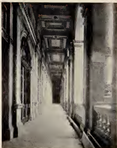
UNO DE LOS CORREDORES LATERALES DE LA SECRETARIA DE COMUNICACIONES Y OBRAS PUBLICAS (EN CONSTRUCCION).
