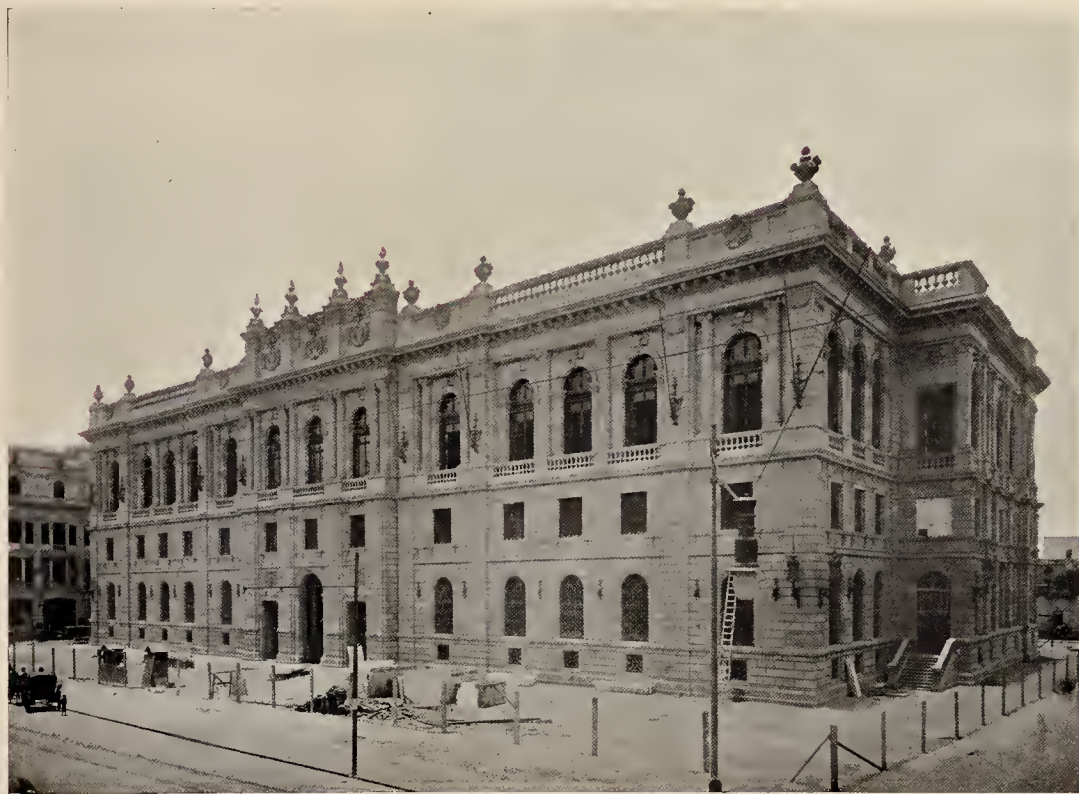
SECRETARIA DE COMUNICACIONES Y OBRAS PUBLICAS (EN CONSTRUCCION).
