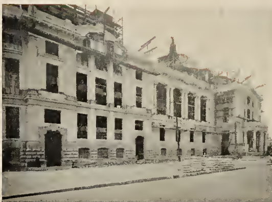
FACHADA LATERAL DERECHA DEL TEATRO NACIONAL (EN CONSTRUCCION).
