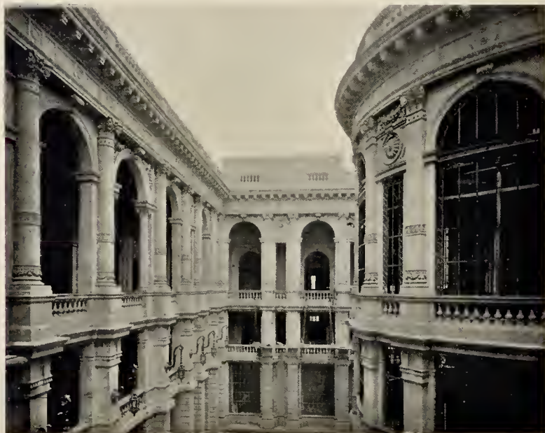
PATIO LATERAL DE LA SECRETARIA DE COMUNICACIONES Y OBRAS PUBLICAS (EN CONSTRUCCION).
