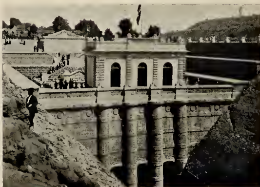
VISTA GENERAL DE LAS OBRAS EXTERIORES DEL TUNEL DE TEQUIXQUAC.
