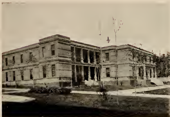
EDIFICIO PARA ALCOHOLICOS EN EL MANICOMIO GENERAL.
