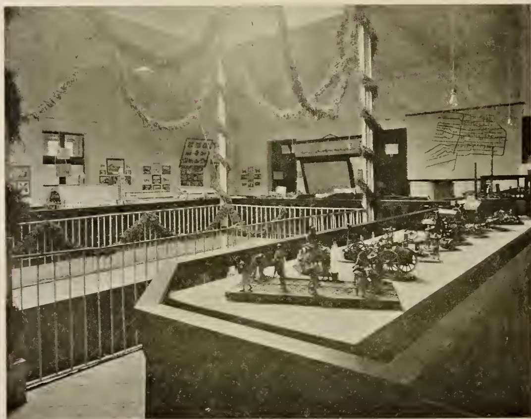
SISTEMAS DE PAVIMENTACION Y LIMPIA DE CALLES EN LA EXPOSICION DE HIGIENE.
