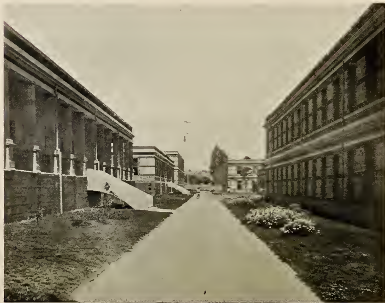
CALLE INTERIOR (NORTE A SUR) DEL MANICOMIO GENERAL.
