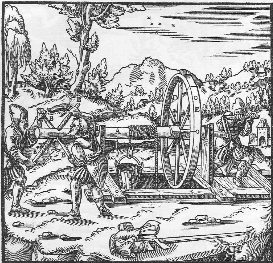
Der Rundbaum A. Die geraden Stäbe, auch Haspelwinden genannt B. Das Haspelhorn C. Die Speichen des Rades D. Die Felgen E.
