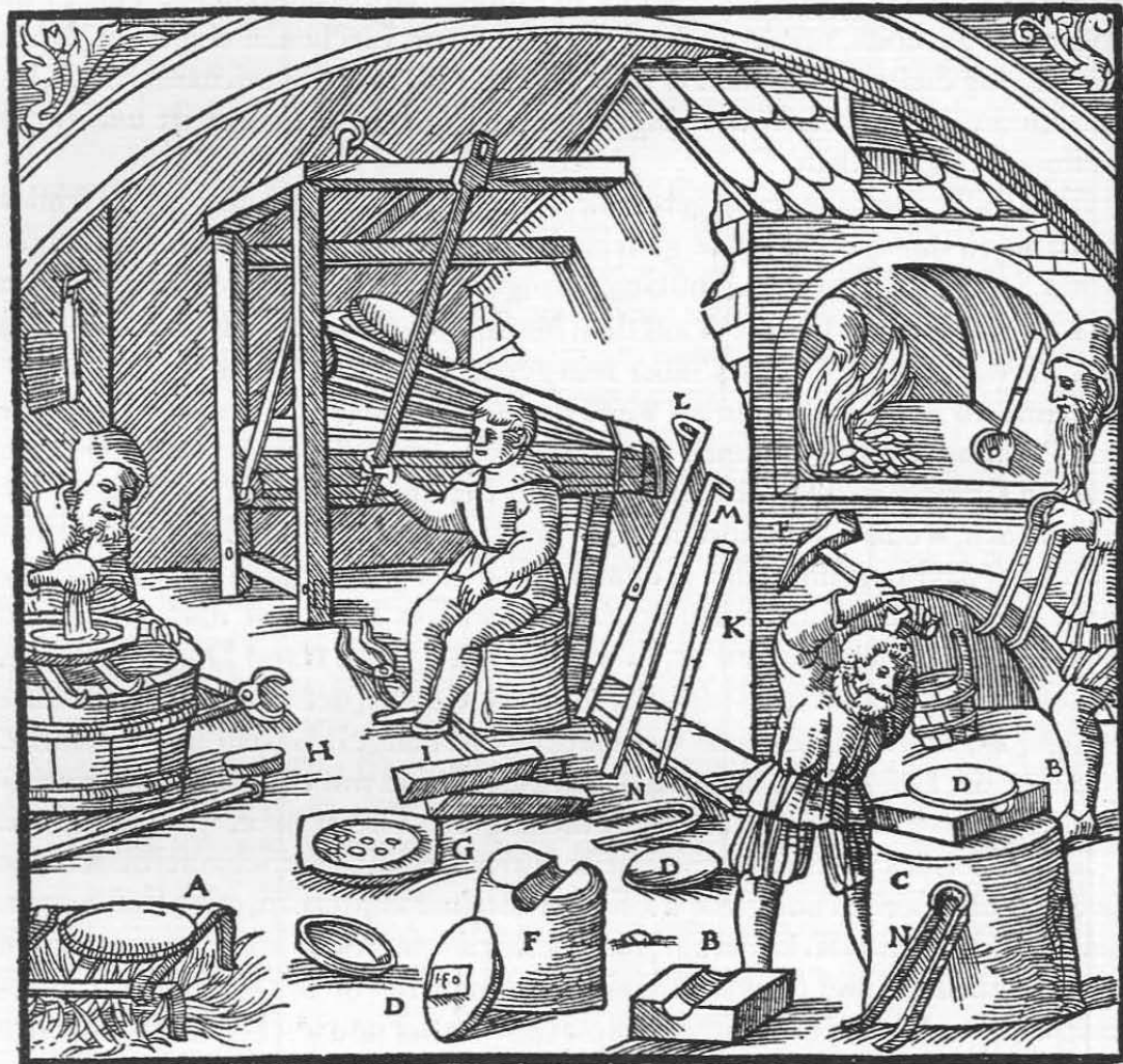
Der Rost A. Die Messingunterlage B. Der Holzklotz C. Das Silberstück D. Der Hammer E. Der Holzklotz, in der Mitte vertieft F. Der Trog mit Löchern G. Das Rundholz, an einem Eisen befestigt H. Tannenholzscheite I. Die Eisenstange K. Das Gezähe mit Aushöhlung (Probelöffel) L. Das Gezähe mit Ring; das Gezähe, dessen Ende aufgebogen ist M. Das Gezähe in Gestalt einer Klemme N.
