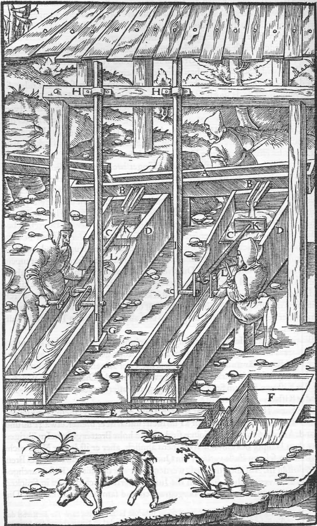
Das obere Quergerinne A. Seine Auslässe B. Die Häupter der Schlammgräben C. Die Schlammgräben D. Der untere Quergraben E. Der Trog F. Das Lager in der Grundschwelle G. Die am Balken angeschlagenen Halbringlager H. Die Stange I. Ihre Kiste K. Die andere Kiste L.
