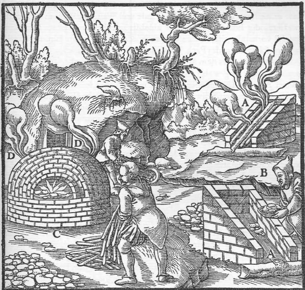
Ein brennender Röststadel mit Bleierz und darauf gelegten Hölzern A.
