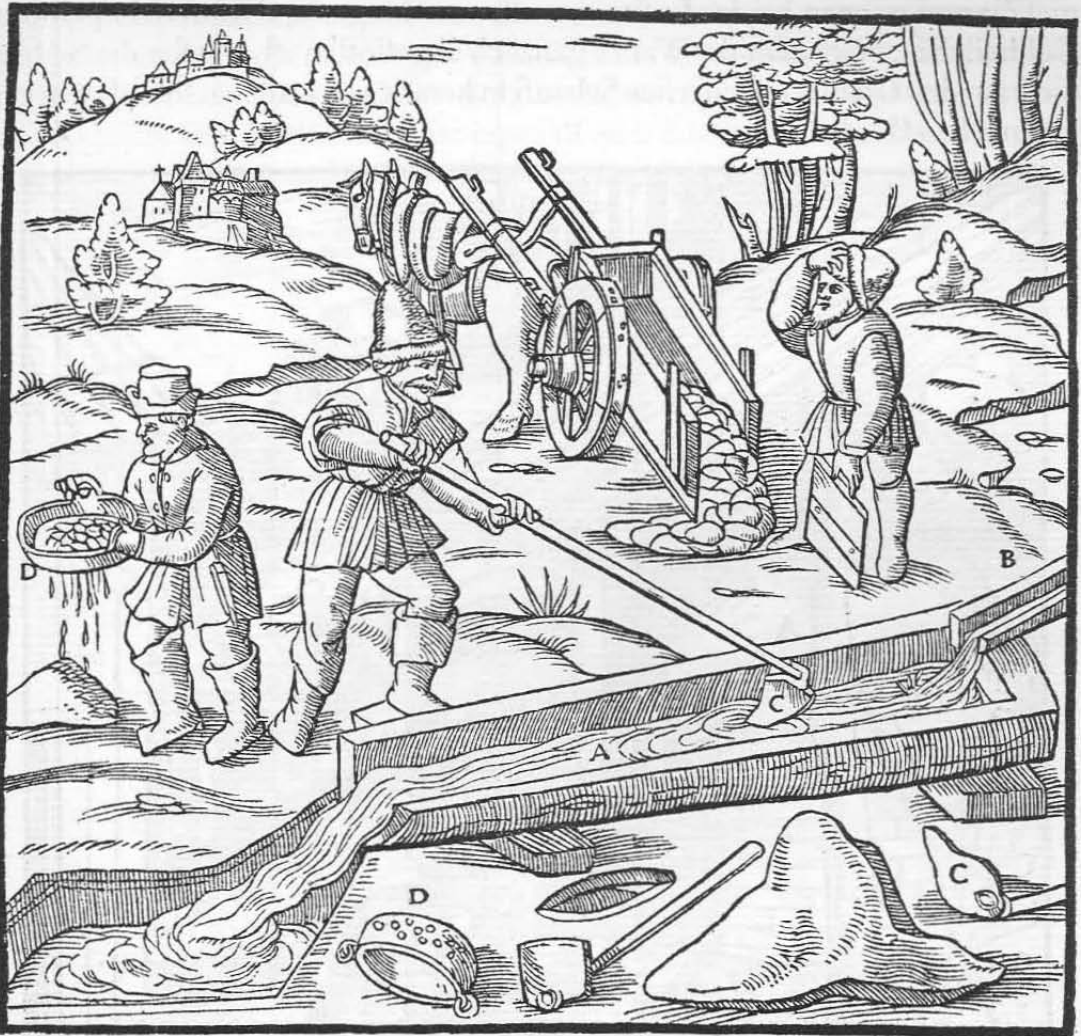
Der Graben A. Das kleine Gerinne B. Die Kratze C. Das Sieb D.
