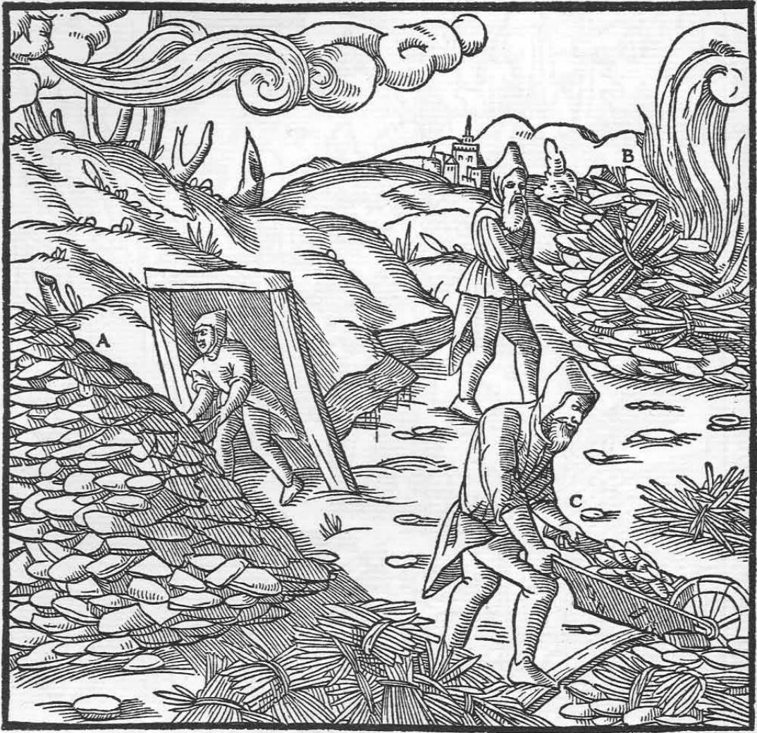
Der Erzhaufen A. Der entzündete Erzhaufen B. Ein Arbeiter, der Schiefer auf das Strauchwerk schafft C.
