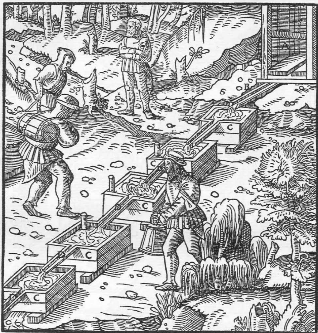
Das Stollenmundloch A. Das Gerinne B. Die Behälter C. Die Überläufe D.
