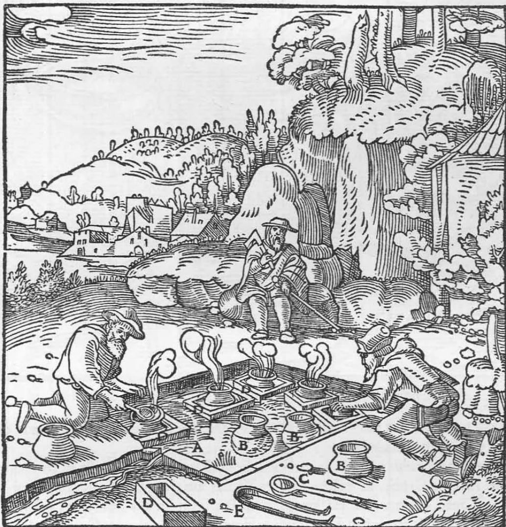
Die Sammelgrube A. Die Töpfe B. Schöpflöffel C. Die Pfanne D. Die Zange E.
