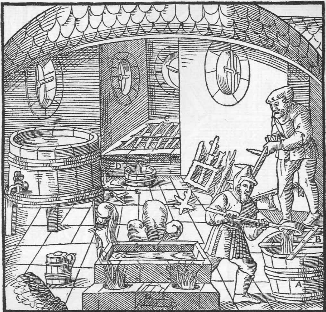
Der Holzbottich A. Die Querstäbe B. Die Ruten C. Der Behälter mit geneigtem Boden D. Das daruntergestellte Gefäß E.
