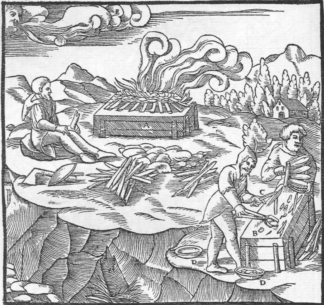
Die Feuerstätte, auf der das Erz erhitzt wird A. Die Feuerstätte, auf der ausfaigerte Wismutkugelchen liegen B. Die Zange C. Die Mulde D. Der Wind E.
