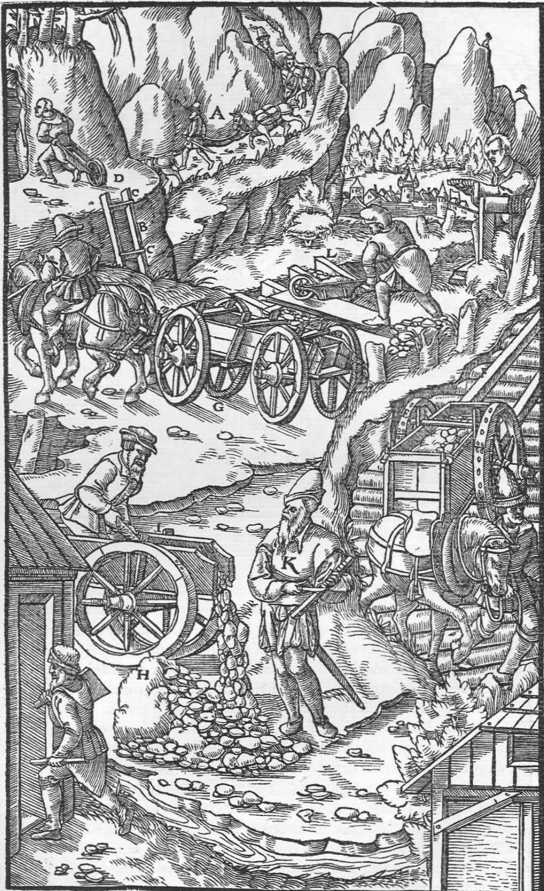
Pferde mit Saumsätteln A. Eine Sturzrolle, geneigt an den Felsen gestellt B. Die zugehörigen Bretter C. Der Karren mit einem Rade D. Der zweirädrige Karren E. Die Baumstämme F. Der Wagen G. Das Erz wird vom Wagen abgeladen H. Die Riegel I. Der Steiger, der die Anzahl Wagen am Kerbholz verzeichnet K. Die Behälter, in die die Erze zur Verteilung geworfen werden L.
