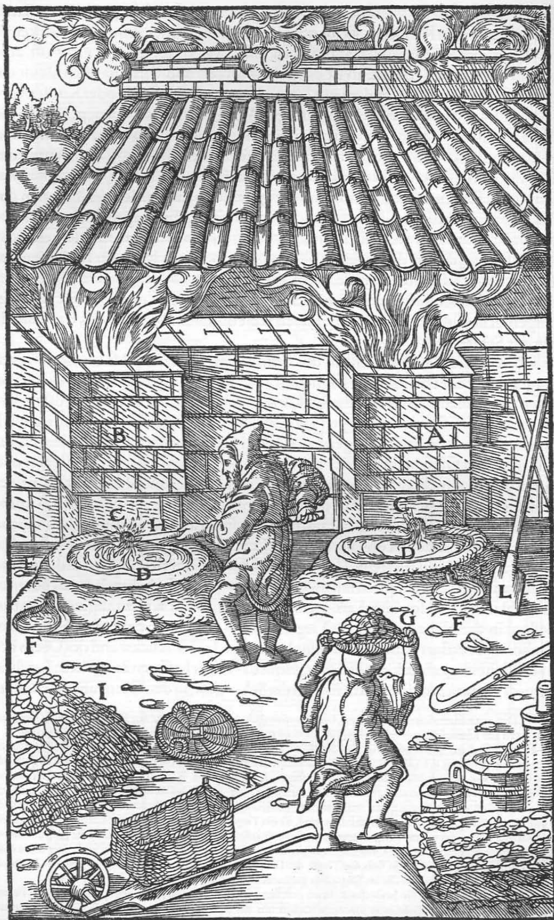
Zwei Öfen A B. Der Stich des Ofens C. Der dicht am Ofen befindliche Vorherd D. Sein Stich E. Der zweite Vorherd F. An den ersten Ofen tritt ein Arbeiter heran, der einen mit Kohlen gefüllten, aus Holzspänen geflochtenen Korb trägt G. Am zweiten Ofen steht ein Schmelzer, der mit einem eisernen Haken die Ansätze entfernt, die sich im Stich gebildet haben. Der eiserne Haken H. Kohlenhaufen I. Karren mit einem aus dicken Ruten geflochtenen Korb, in dem die Kohlen abgemessen werden K. Eiserner Spaten L.
