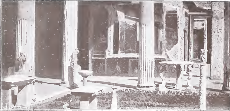
Das Peristil eines pompejanischen Hauses
