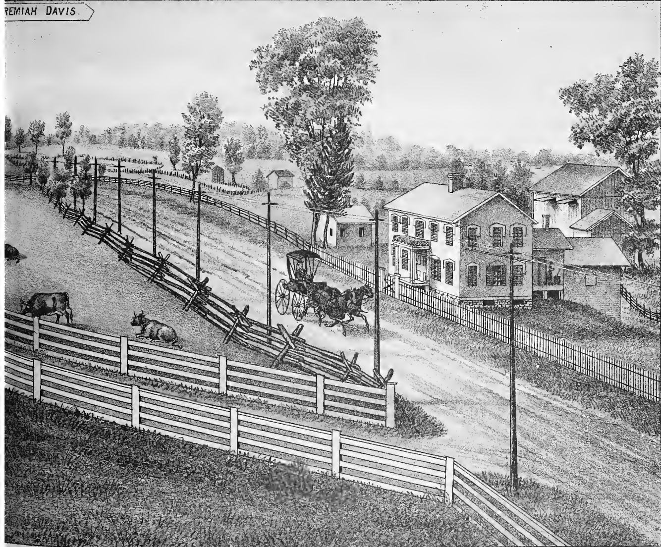
BRIAR HILL, (MORRISTOWN) ST. LAWRENCE Co., N. Y.
