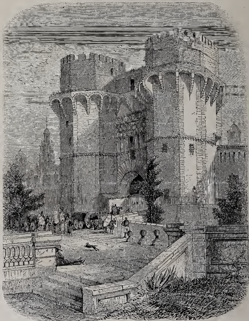
Porte de Serranos , à Valence (1); construction mauresque. — Dessin de Rouargue.
