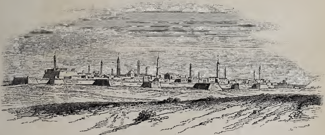
Candie vue du côté de la terre.
