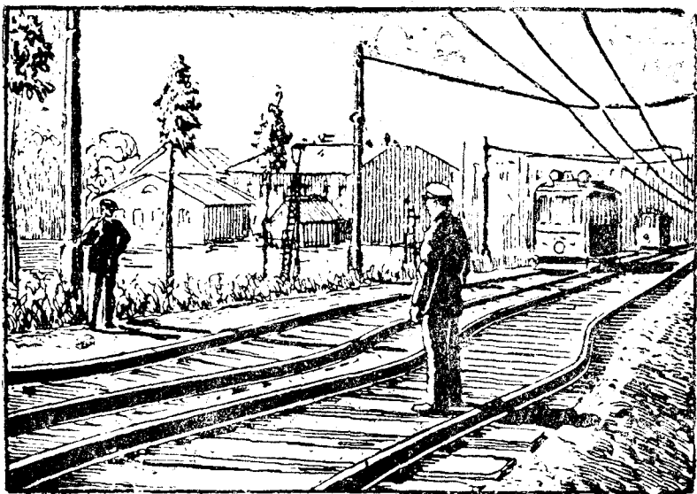
第五十七圖 鐵軌因劇烈膨脹而損壞路綫
