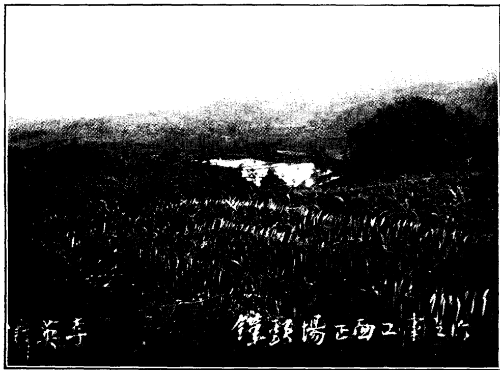
鐘 頭 場 工 事 (一)
