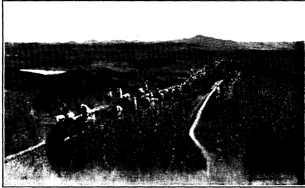
上 兵 構 築 工 事 (二)
