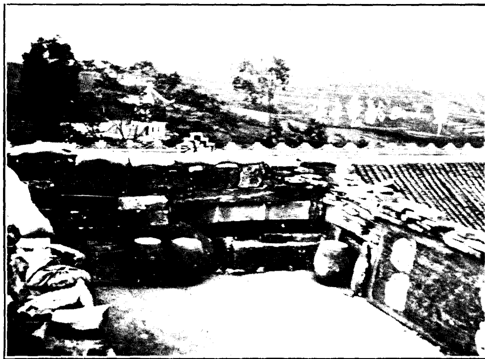
資 中 重 龍 山 工 事 (一)
