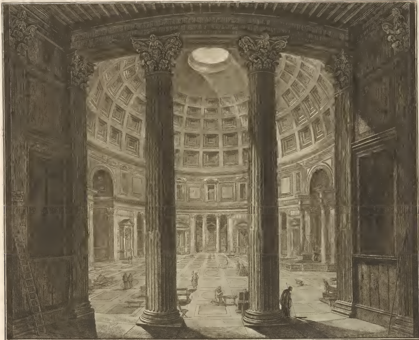
Veduta interna del Pantheon. Questo tempio, fabbricato da M. Agrippa e di forma rotonda, oltre quattro il suo diametro. Il primo ordine è tutto antico. Le due colonne principali sono di giallo come le due della Tribuna qua l'anno sono state tolte dalla rovina della loro situazione. Le altre sono di marmo ed il piano di porfido. Il secondo ordine è moderno a riserva delle cornici di marmo di porfido di giallo, e di serpentino che l'abate vani furono tolte da PP. Benedetto XIII perchè rinacciavano ruina, e fu adornato di stucchi come si vede al presente. L'altare maggiore è moderno fabbricato da Clemente XI. Gli otto altari minori sono antichi, come ancora il pavimento composto di giallo di granito, e di porfido.
