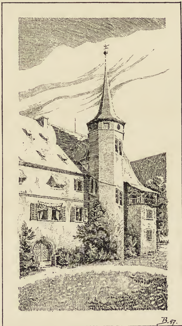
Fig. 109. Rust. Schloss, Hofansicht.
