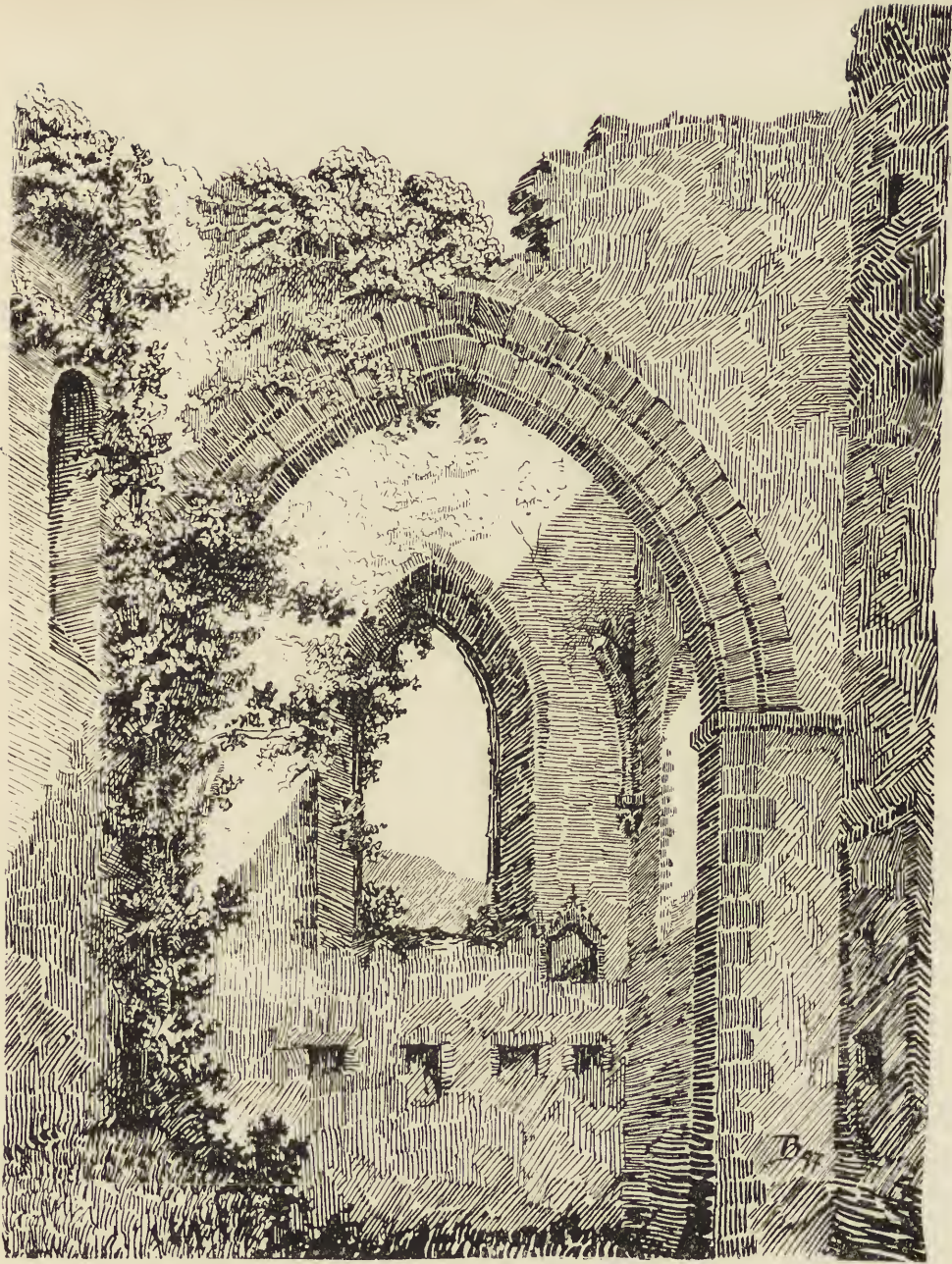
Fig. 75. Landeck. Blick in den Chor der Kapelle der unteren Burg.
