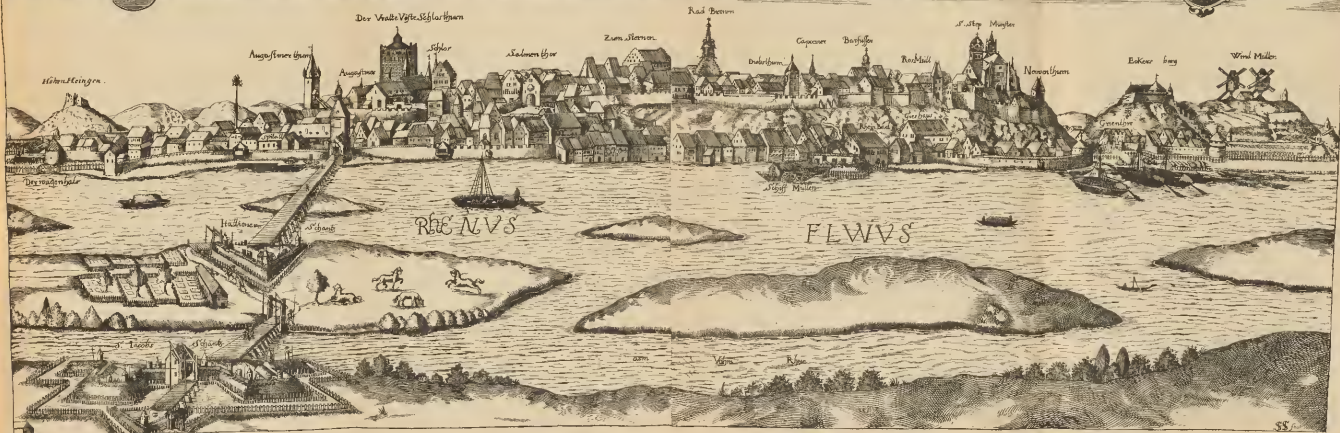
Fig. 3. Breysch. Ansicht der Stadt, aufgenommen erstreckte vor 1697, oder zwischen 1703 und 1714
