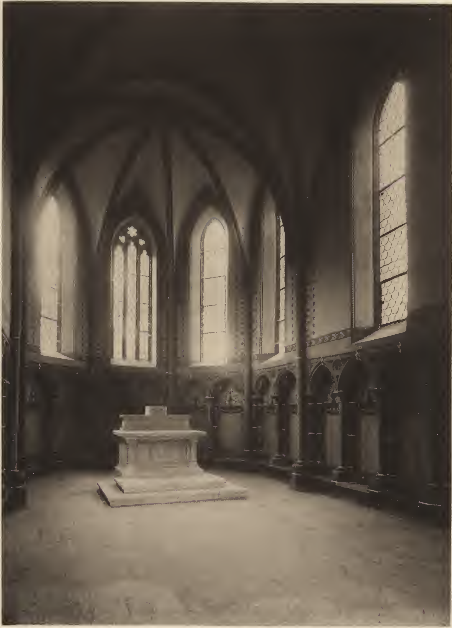
Thennenbach. Kapelle, Innenansicht (nach der Restauration).
