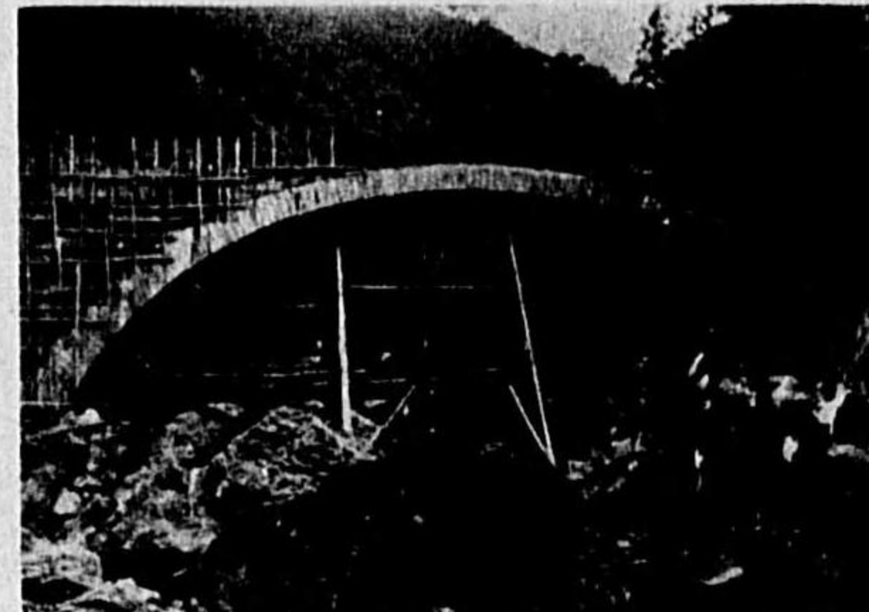
青待橋 側壁型枠組立圖
