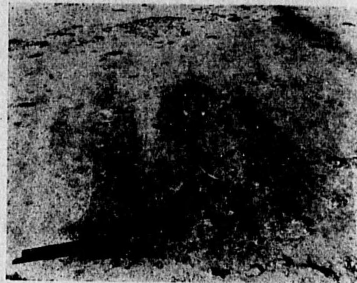
寫眞-5 アスファルト處理道 (磨耗層乳剤 3立/m 2 15mm 級碎石)
