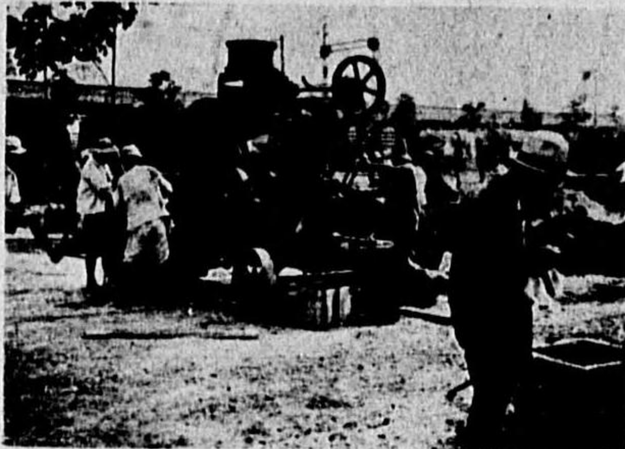
写真-3 ソイルコンクリート鋪設
