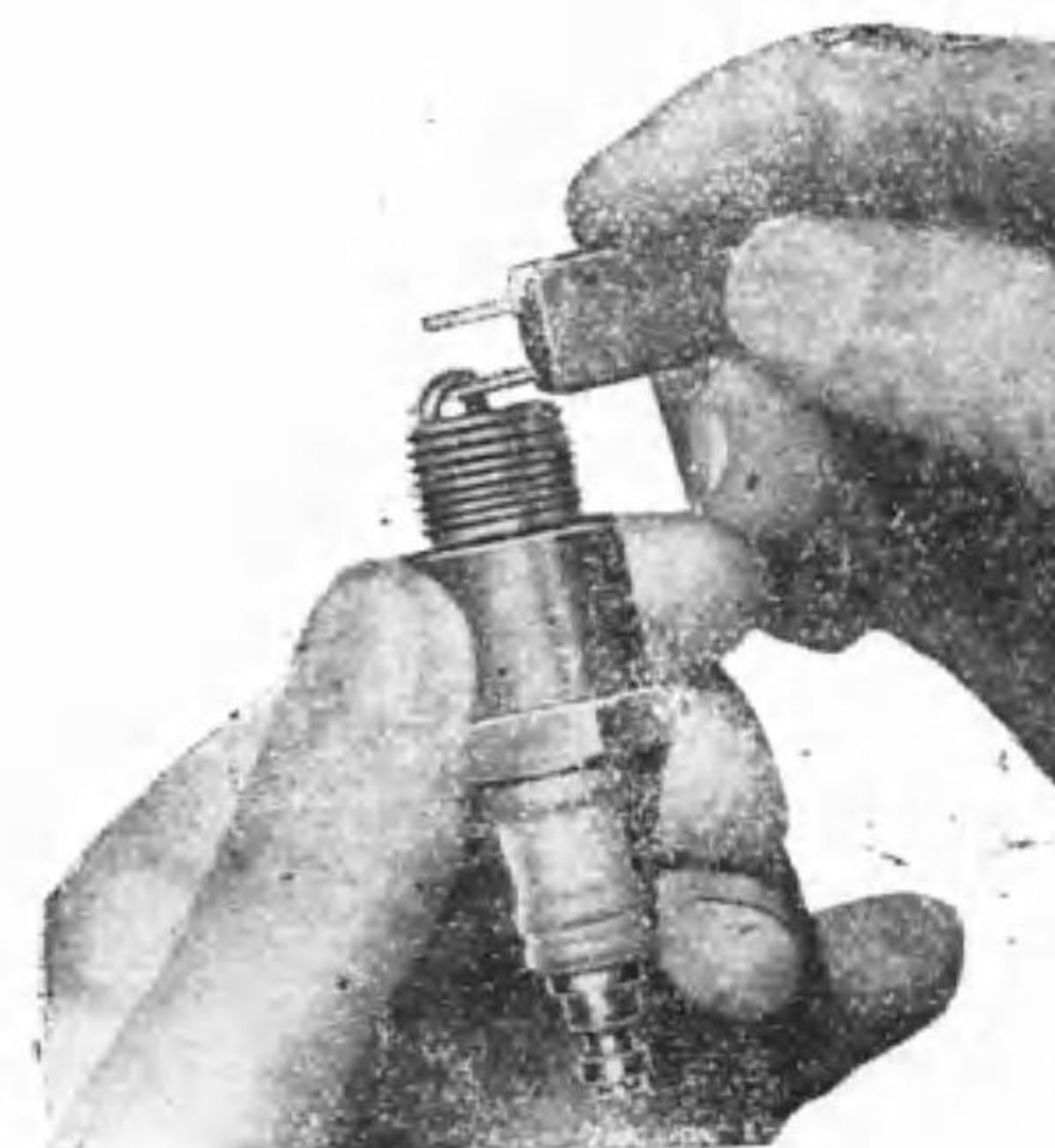
第61圖 點火栓の間隙調整
