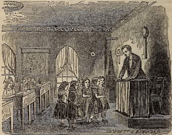
THE FALLEN STUCCO.
