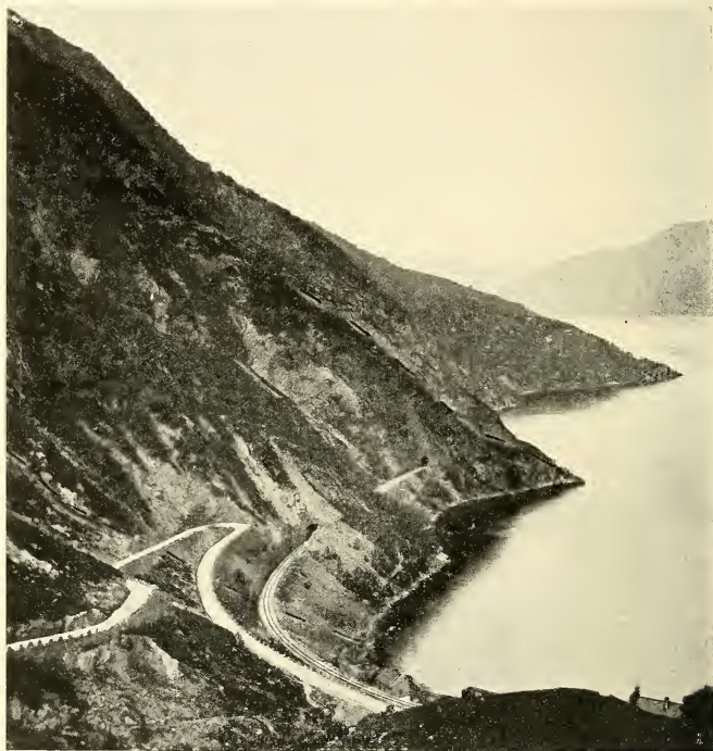
Fig. 87. Utsigt fra Trengereidgaardene vestover langs jernbanelinjen. Nærmest tilskueren sees den graa sericitgneis ved Trengereid station (XXXVIII). Dernæst følger en lang sone av flasersaussuritgabbro (XXXVII). Utenfor denne kommer flere smale soner av forskjellige bergarter. I det ytterste nes ved garden Risnes staar der gneis som tilhører Ulrikkens gneisfelt.
