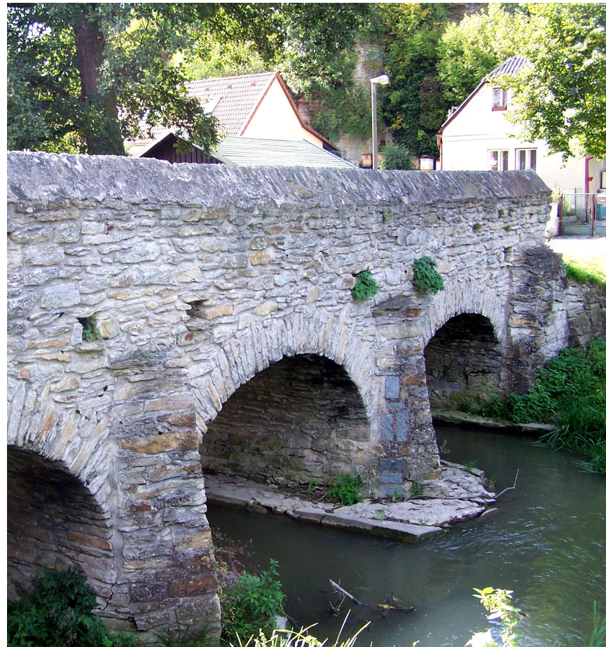
Kamenný most přes Zlatý potok
