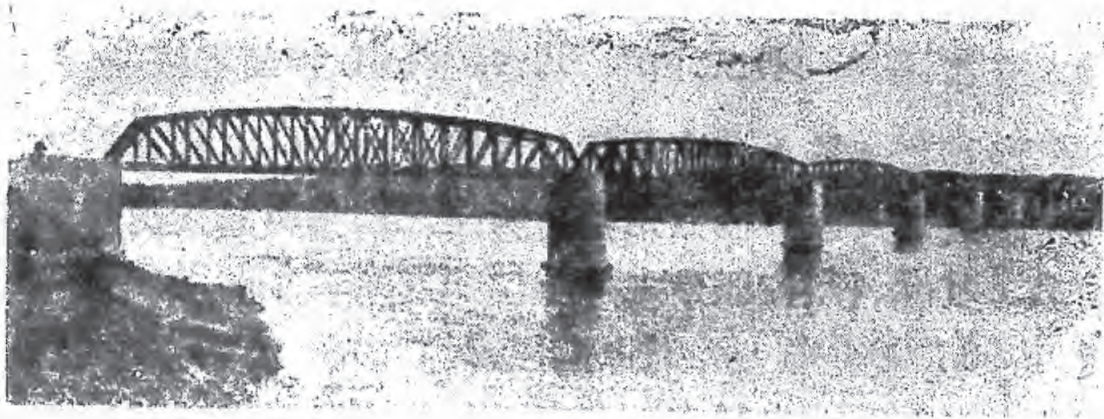
東海岸鐵道克蘭灘河幾內馬橋全景圖
