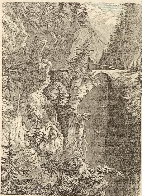
Die zweite Brücke in der Viamala.
